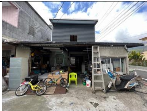
建築入口為半開放空間
