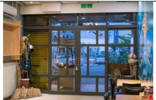
出入口落地窗更換，增加通透性
