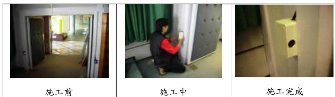
圖 8-10 紅外線計數系統設置現況圖
