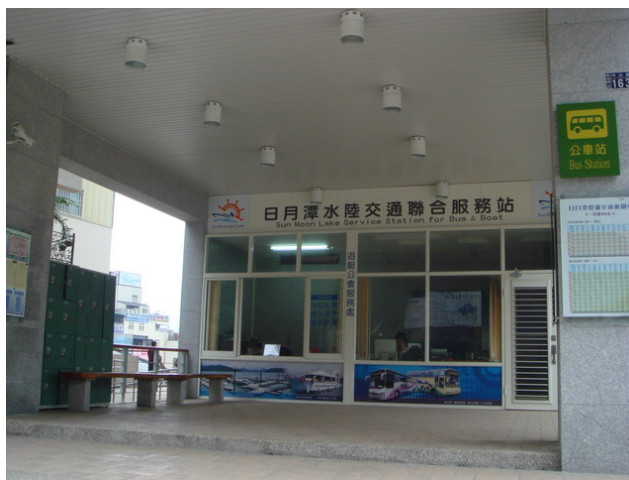
圖 4.1-3 水社遊客中心旁之水陸交通服務站
