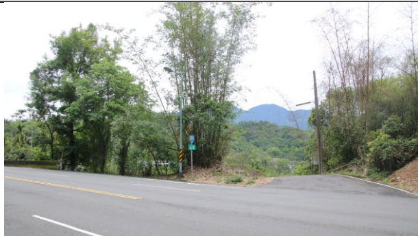
2. 工區北側現況
