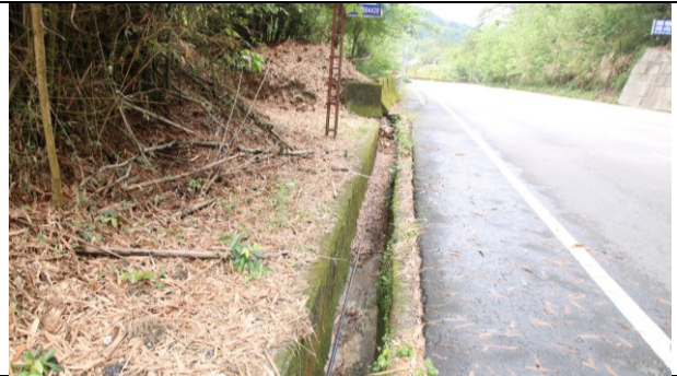
1-2. 工區前溝渠現況
