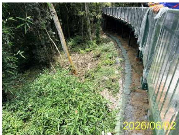
步道橋側邊坡自然草本植被回復
