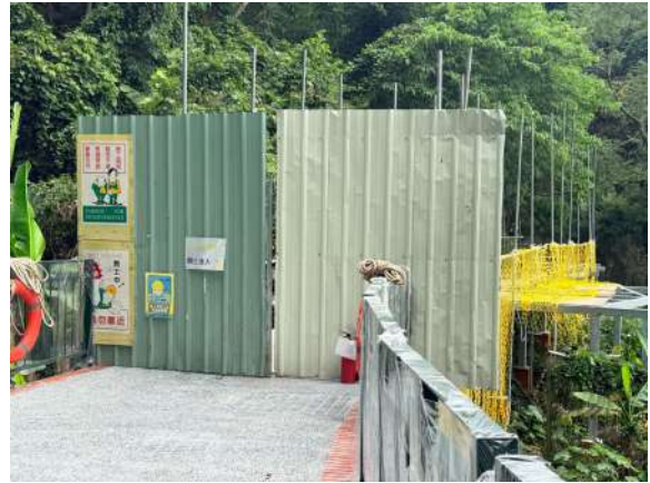
施工區內管制
