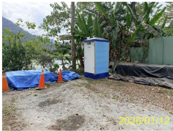
材料暫置區已妥善覆蓋
