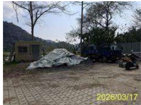
圖2. 施工工區現況
