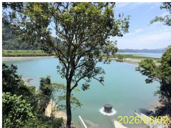
大竹湖水域全景（溢流口正常出水）
