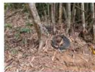
缺失-2 材料堆置
