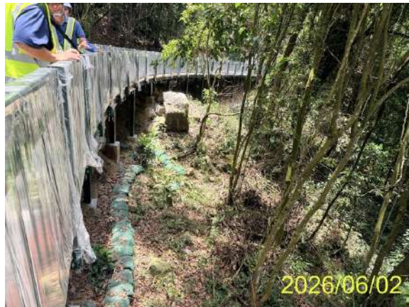
步道橋下砂包護坡防護
