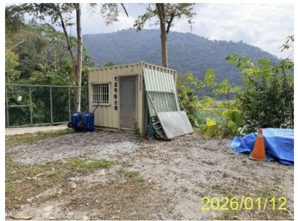
材料暫置區已妥善覆蓋
