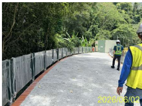
步道鋪面施作路況
