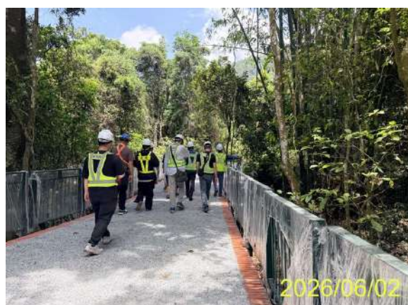
現勘人員巡視步道施工段
