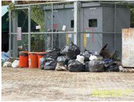
圖9. 工區廢棄物堆積現況
