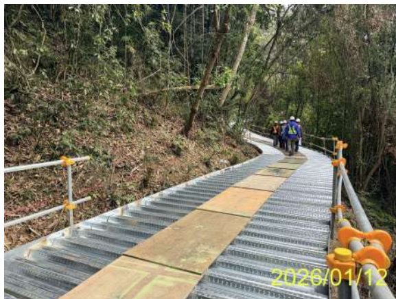
施工區內情況
