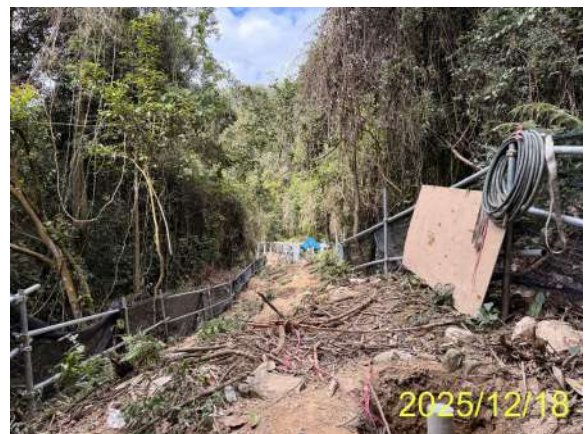
施工區內現況
