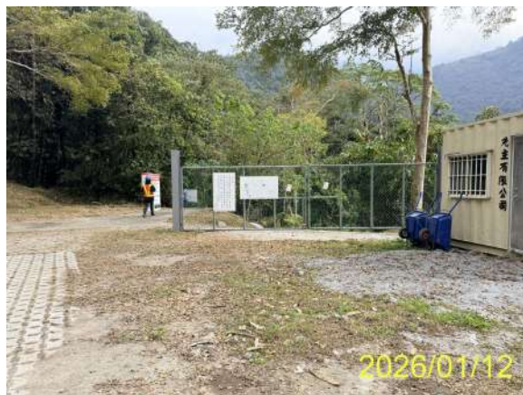
施工區入口處
