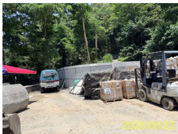
工區材料暫置區（叉車機具作業中）
