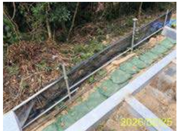
路徑下方已設黑網隔離及土包袋
