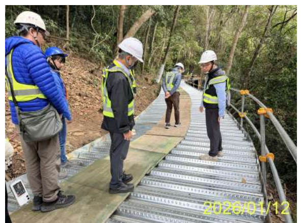
施工區內情況
