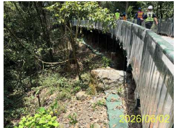
步道橋下溪谷砂包防護（另一角度）
