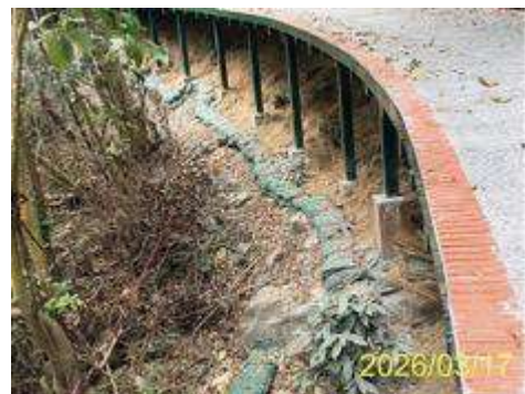
圖8. 邊坡砂包防護措施
