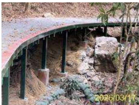
圖5. 步道橋面下方砂包防護
