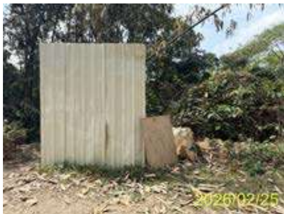
發電機位置可設置警示
