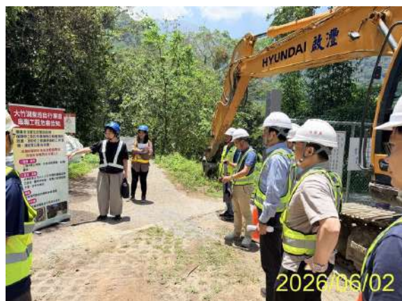
現勘人員進場現況
