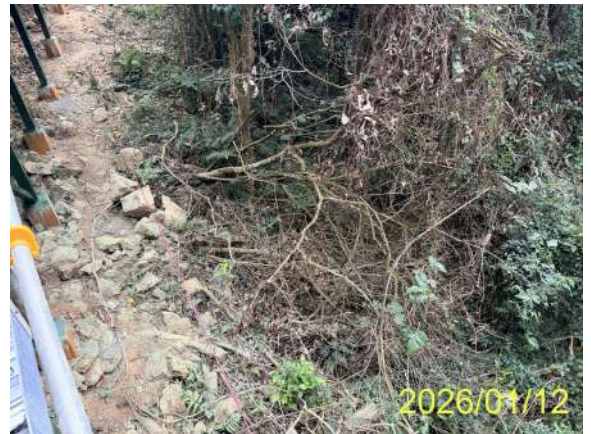
已完成作業之樁柱旁之植被清除後之裸露地 應鋪設稻草蓆
