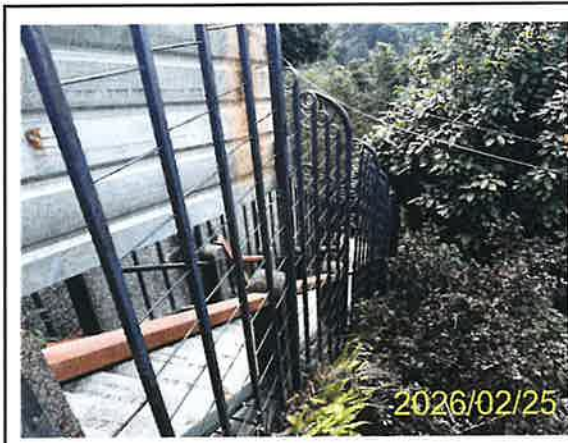
年梯施工現況
