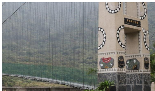
露布露莎吊橋
