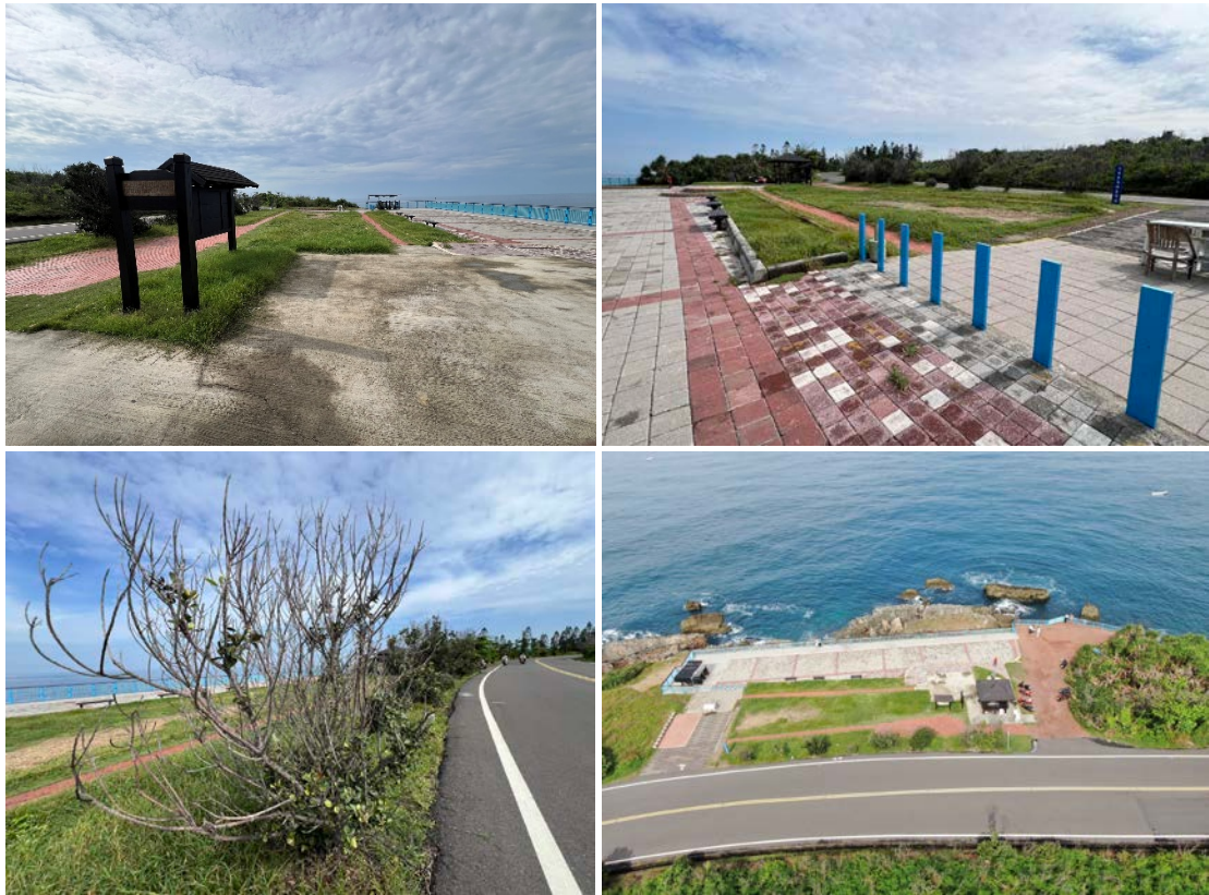
圖 7 落日亭修繕工程環境現勘影像
