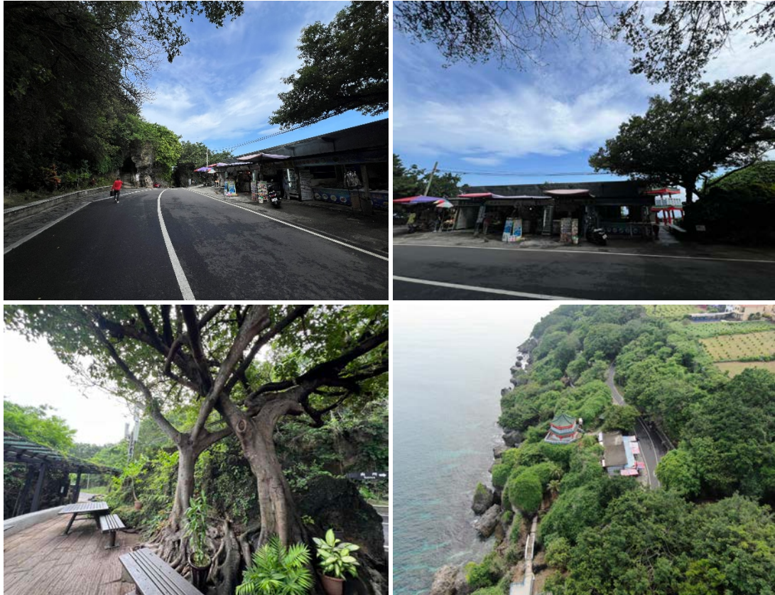
圖 5 山豬溝賣部環境周遭環境現勘現況
