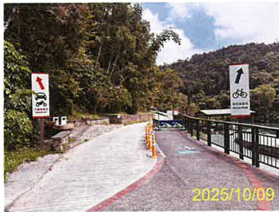
施工區外已設置圍籬
