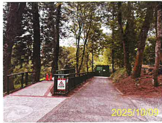
施工區入口管制破標示
