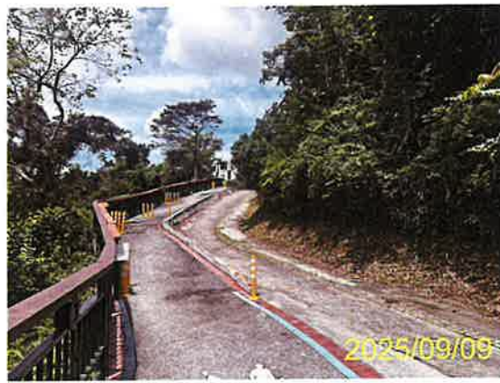
施工便道現況
