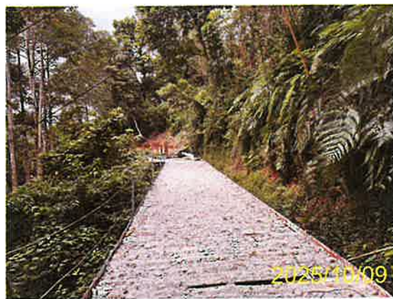
施工區內現況, 應注意標示
