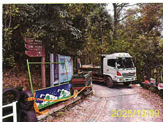
施工區內現況, 已拉警示
