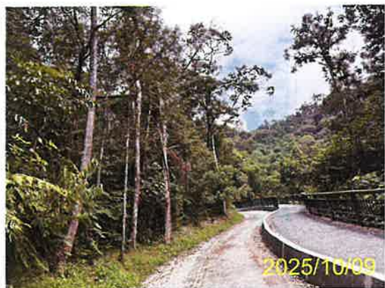
施工區外道路
