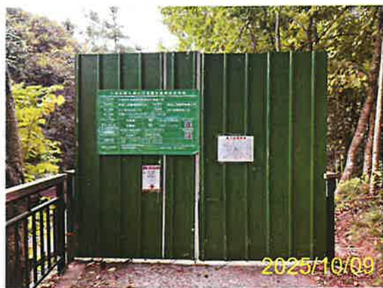
施工另側入口管制
