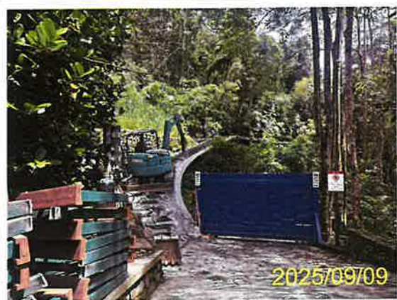
施工區內現況
