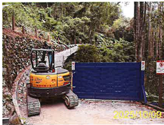
施工區內現況
