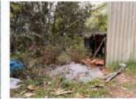
缺失-4 水泥砂漿逸散
