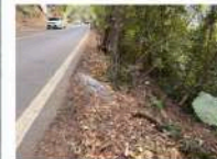
缺失-5 水泥砂漿逸散
