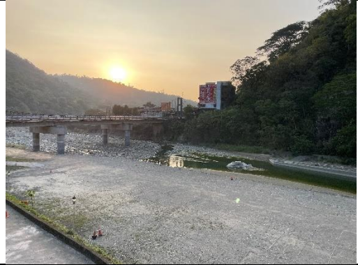
既有橋梁及八掌溪現況 拍攝日期：113年2月1日
