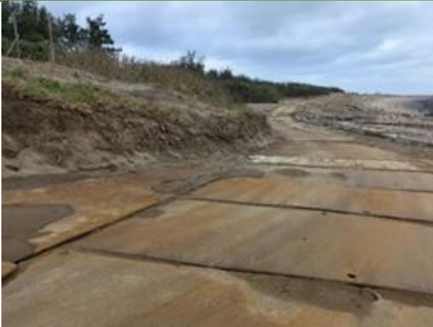
113年12月12日(施工進度約7.61%)，施工便道增加鋼板，建置機具移動路徑。
