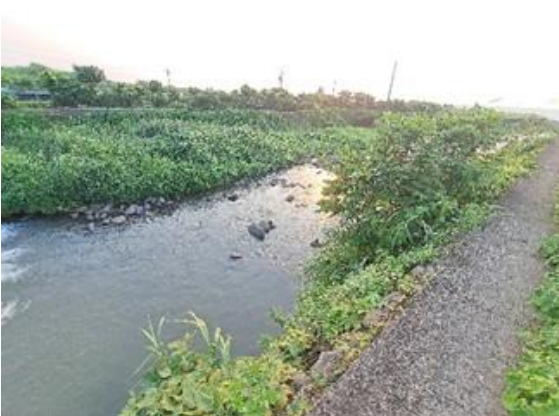
跨橋下游之環境狀況
