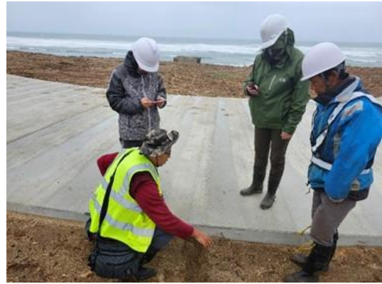
說明：114 年 3 月 28 日討論貼地自行車道兩側回填覆土的形式。
