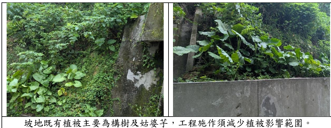
圖 3 台北圓山大飯店金龍廳前方邊坡整治委託設計監造服務案周遭環境情形
