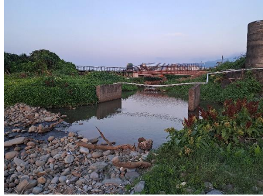
本團隊於 114/5/29 竣工後現勘現地情形-山豬掘下坑跨橋完工。
