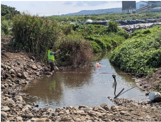
本團隊於 113/9/20 第二次抽查現地情形-山豬堀下坑跨橋便道施作與水域動物監測。
