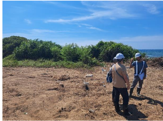
113 年 8 月 27 日(施工進度約 1%)，移除工區周邊入侵植物-銀合歡與大花咸豐草，以利原生種植物拓殖。
