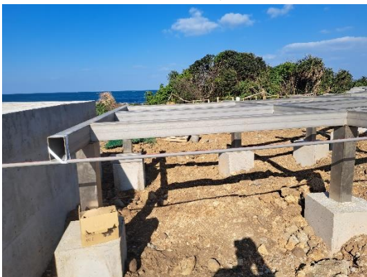
114 年 1 月 13 日(施工進度約 35%)，溪流及草澤附近段落車道設置為高架，以利陸蟹穿越通行。
