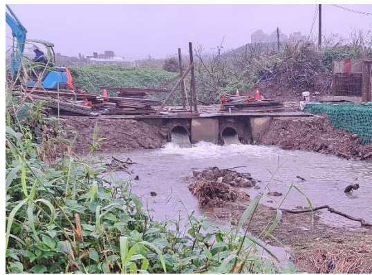
113 年 11 月 21 日(施工進度約 16%)，山豬堀下坑跨橋工程之跨溪便道下方，鋪設涵管維持流路暢通。
