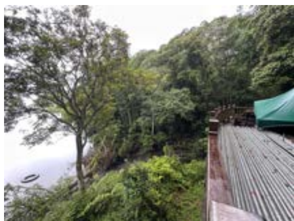
臨大竹湖停車場工區周邊水域現況。(20250602)
