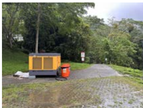
臨大竹湖停車場工區現況。(20250602)
