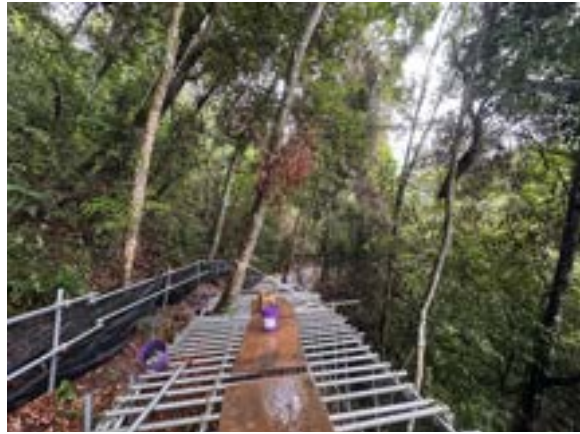
臨大竹湖停車場工區現況。(20250602)
