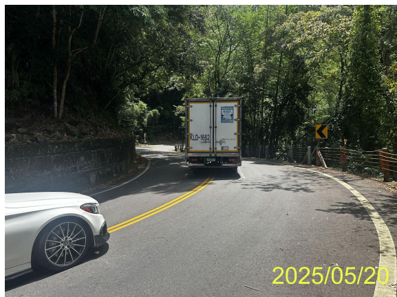
本案上邊坡離路極近，且路肩較小，請注意 後續施工之交維
