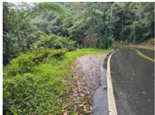
台21甲線道路旁較寬闊處。(20250602)
