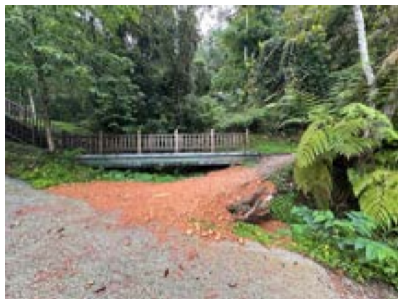
臨大竹湖停車場工區現況。(20250602)
