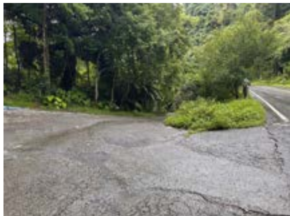
台21甲線道路旁通往潭區之產業道路。(20250602)
