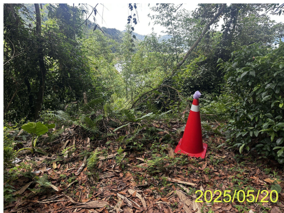
施工處邊坡上方已有放置三角錐
