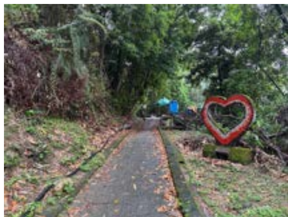
臨大竹湖停車場工區現況。(20250602)
