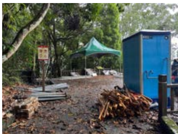
臨大竹湖停車場工區現況。(20250602)
