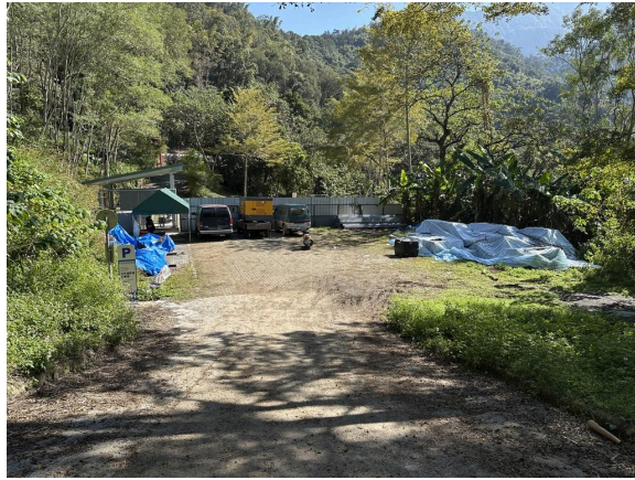
施工材料集中堆置管理 (20250117)
