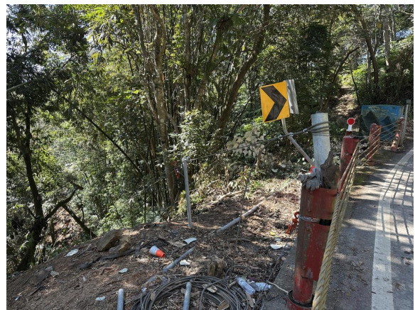
路邊吊索架設起點現況 (20250117)
