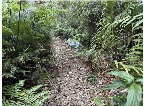
工區外發現部分施工物品散落。(20250423)
