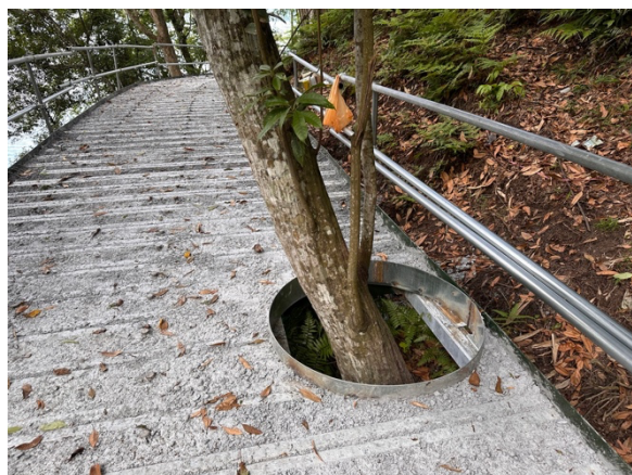
臨近工區之受保全喬木現況。(20250520)
