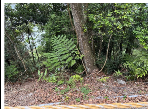
台 21 甲線俯瞰施工位置，周邊林地出現明顯材料運輸路徑。(20250520)
