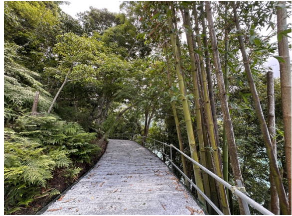
工區步道現況。(20250520)
