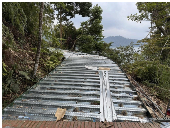
工區步道現況。(20250423)
