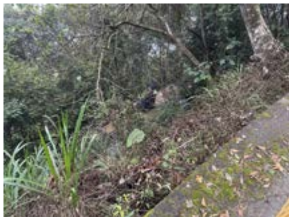
台21甲線俯瞰施工位置。(20250307)
