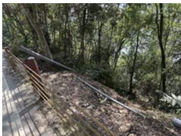
台21甲線旁運輸管路現況。(20250219)
