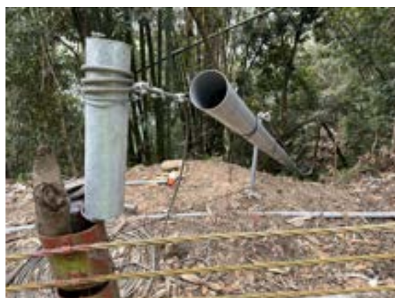
路邊吊索及運輸管路架設起點現況。(20250219)
