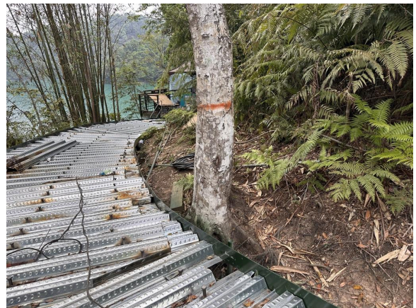
臨近工區之受保全喬木現況。(20250423)
