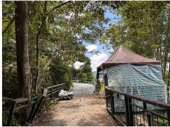
工區步道現況。(20250520)
