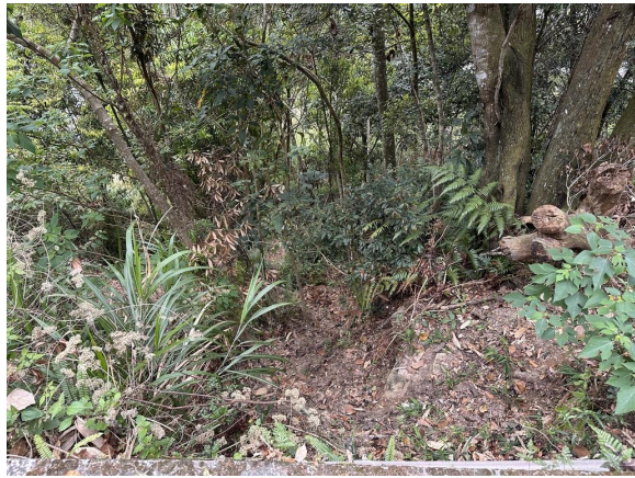
台21甲線俯瞰施工位置，周邊林地出現明顯材料運輸路徑。(20250423)
