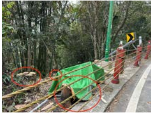
台21甲線周邊樹木受損情形（紅圈框起處）。(20250219)
