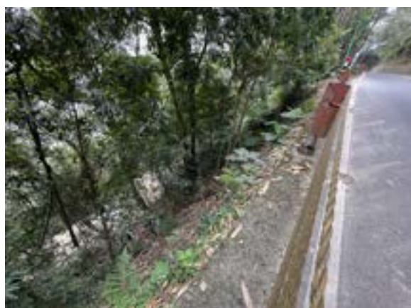
台21甲線俯瞰施工位置，周邊林地出現明顯材料運輸路徑。(20250219)
