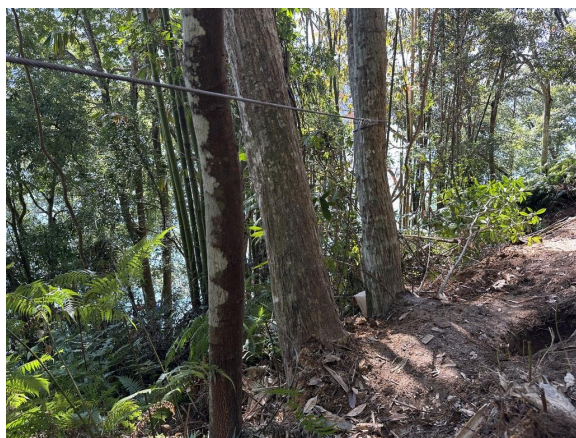
工區內吊索架設終點現況 (20250117)
