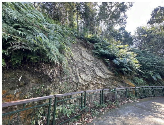
工區外既有步道因滑坡造成損害 (20250117)
