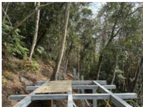
臨近工區之受保全喬木現況。(20250219)
