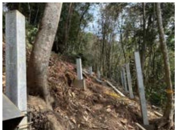
臨近工區之受保全喬木現況。(20250219)
