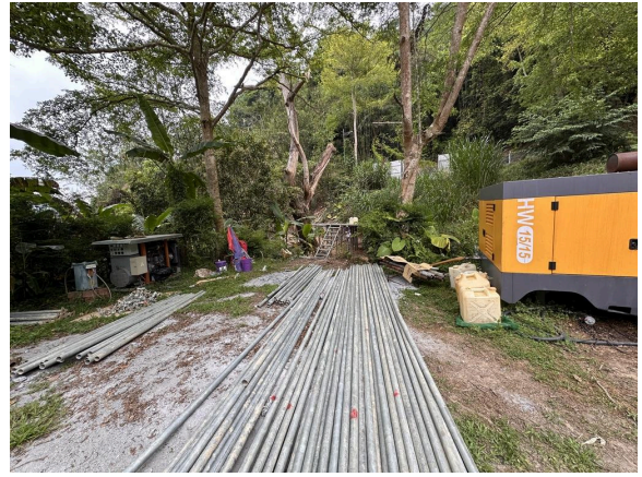
臨大竹湖停車場工區現況。(20250423)
