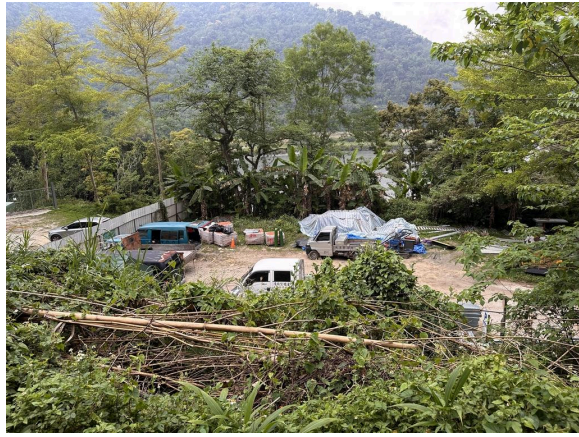
台21甲線俯瞰施工位置。(20250423)
