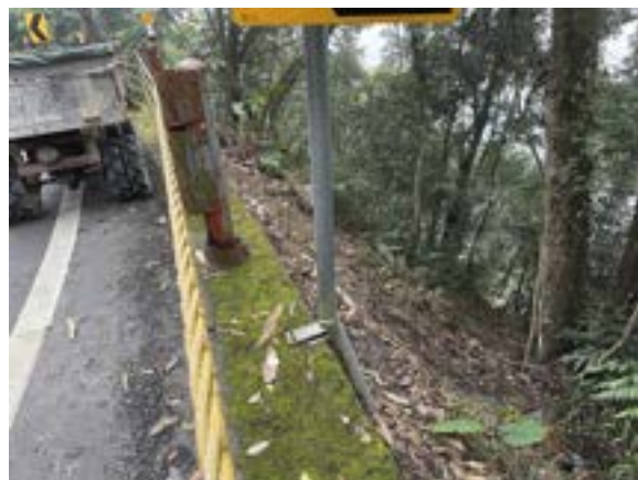
台21甲線俯瞰施工位置，周邊林地出現明顯材料運輸路徑。(20250307)
