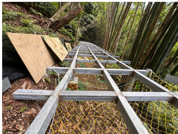
施工路徑下方已設置防墜落網。 (20250520)
