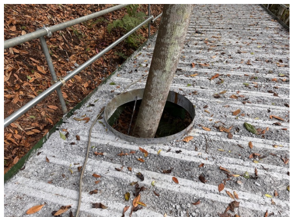
臨近工區之受保全喬木現況。(20250520)
