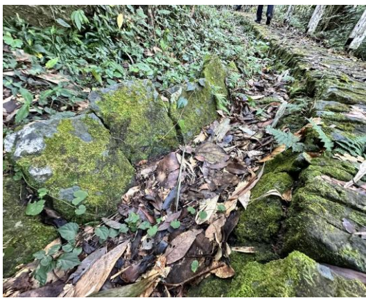
圖 44、步道邊坡砌石溝
