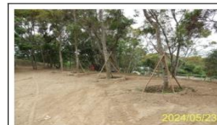
施工區內現況
