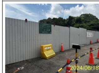
現地施工圍籬
