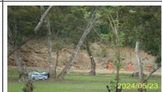
施工區內警示錐設置
