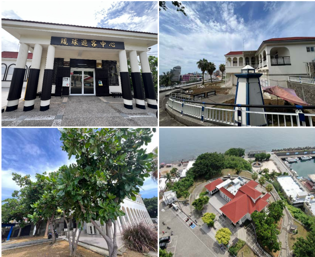
圖 3 琉管站環境周遭環境現勘現況
