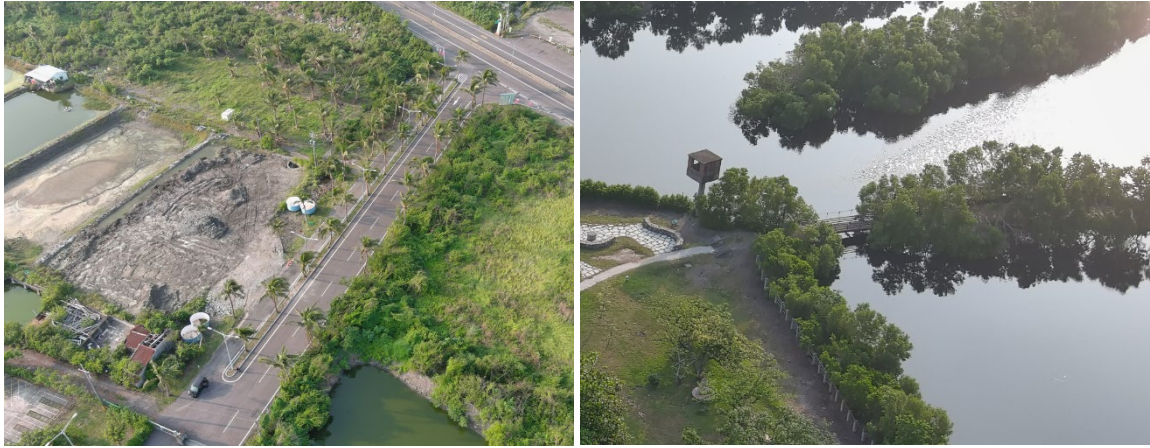
圖 5 案二人行道及吊橋周遭植群現況(二)
