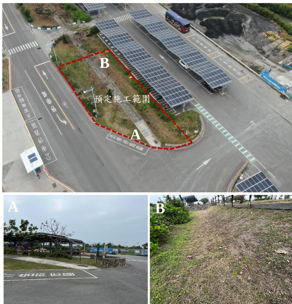
圖 5 本案預定施工範圍空拍周遭現況
