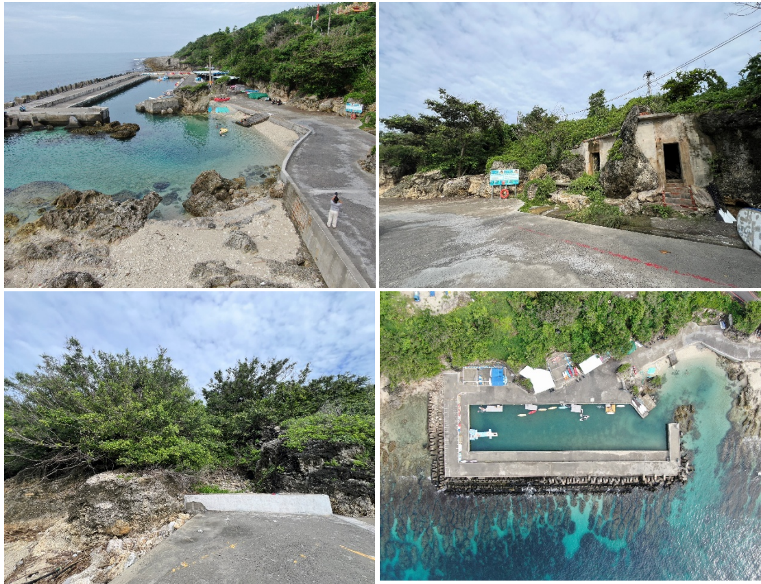
圖 8 大福西修繕工程環境現勘影像
