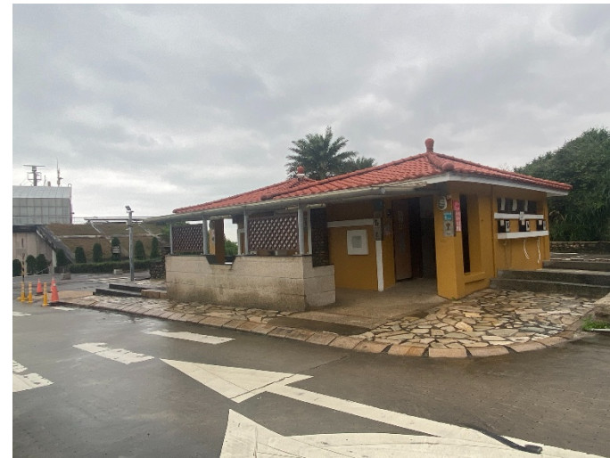
場域旁停車場設有符合無障礙公廁及附設沖水設施，便利來訪遊客。
