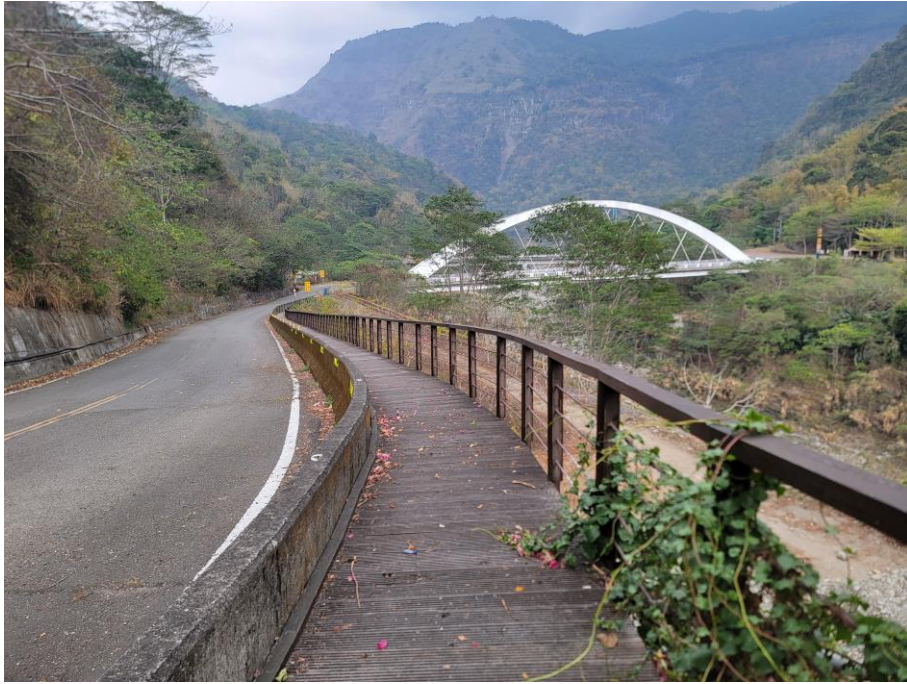
山美既有步道修繕位置照片
