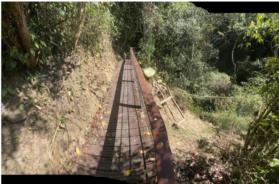
福山古道崩塌處木棧道施作位置照片
