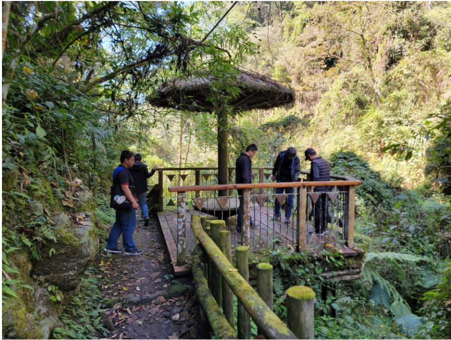
福山古道既有休憩亭修繕照片
