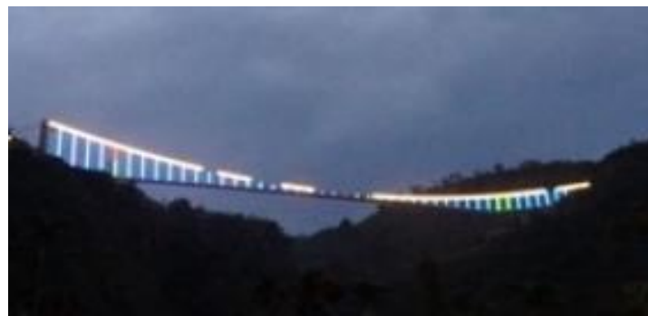
既有燈具皆設置於橋的較高位置 (部分燈具損壞維修困難)
