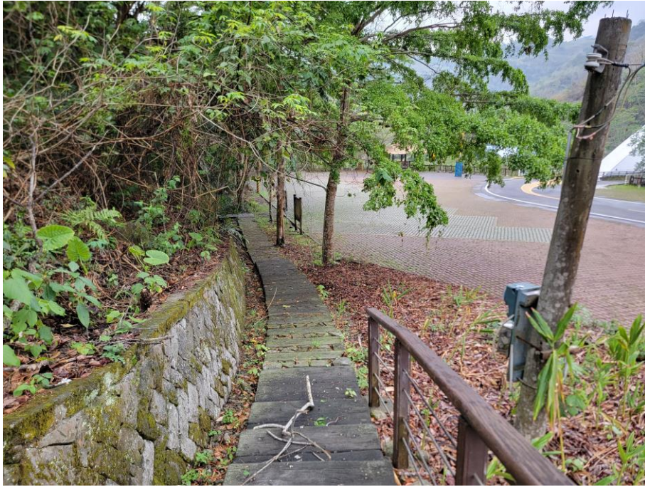
山美既有步道修繕位置照片
