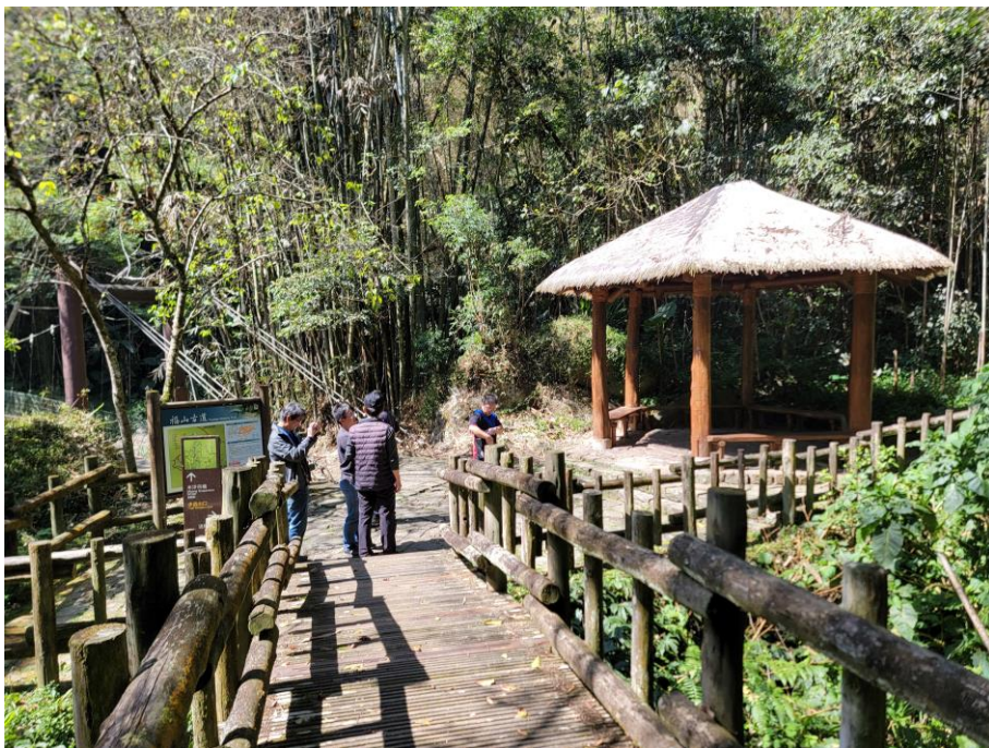
福山古道(米洋吊橋旁)休憩亭整修位置照片
