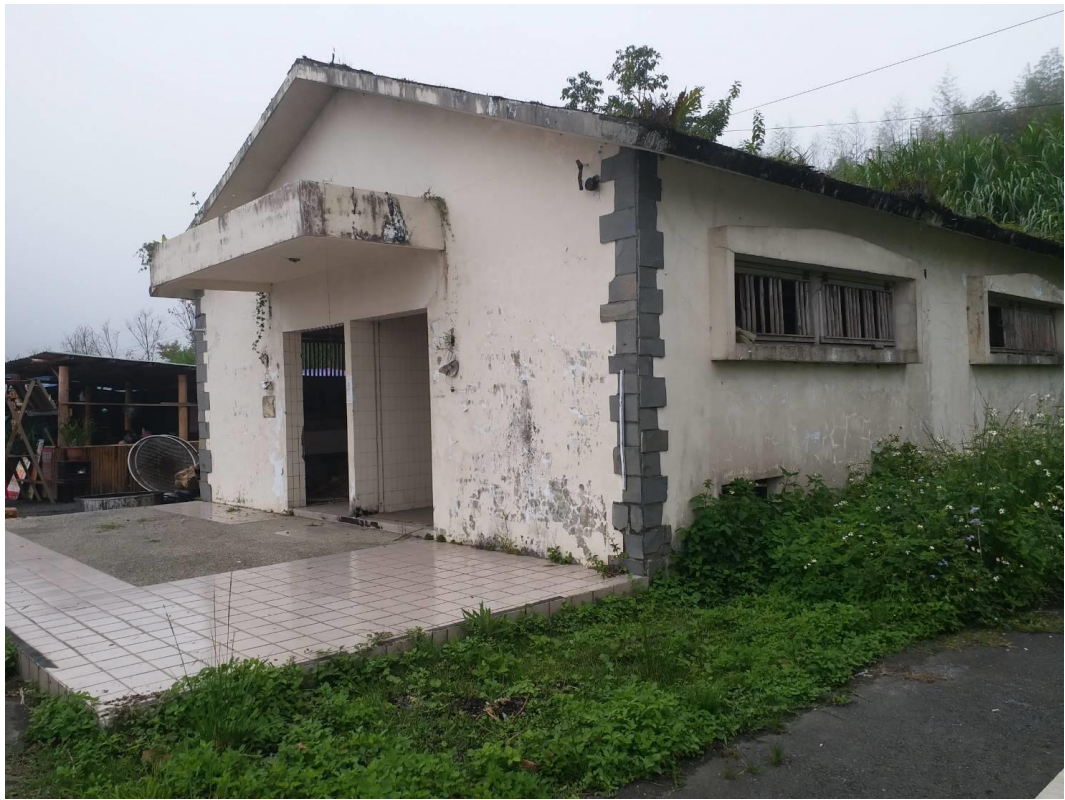
工區三：既有公共廁所現況照片
