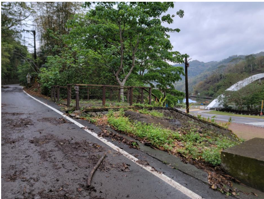
山美既有步道修繕位置照片
