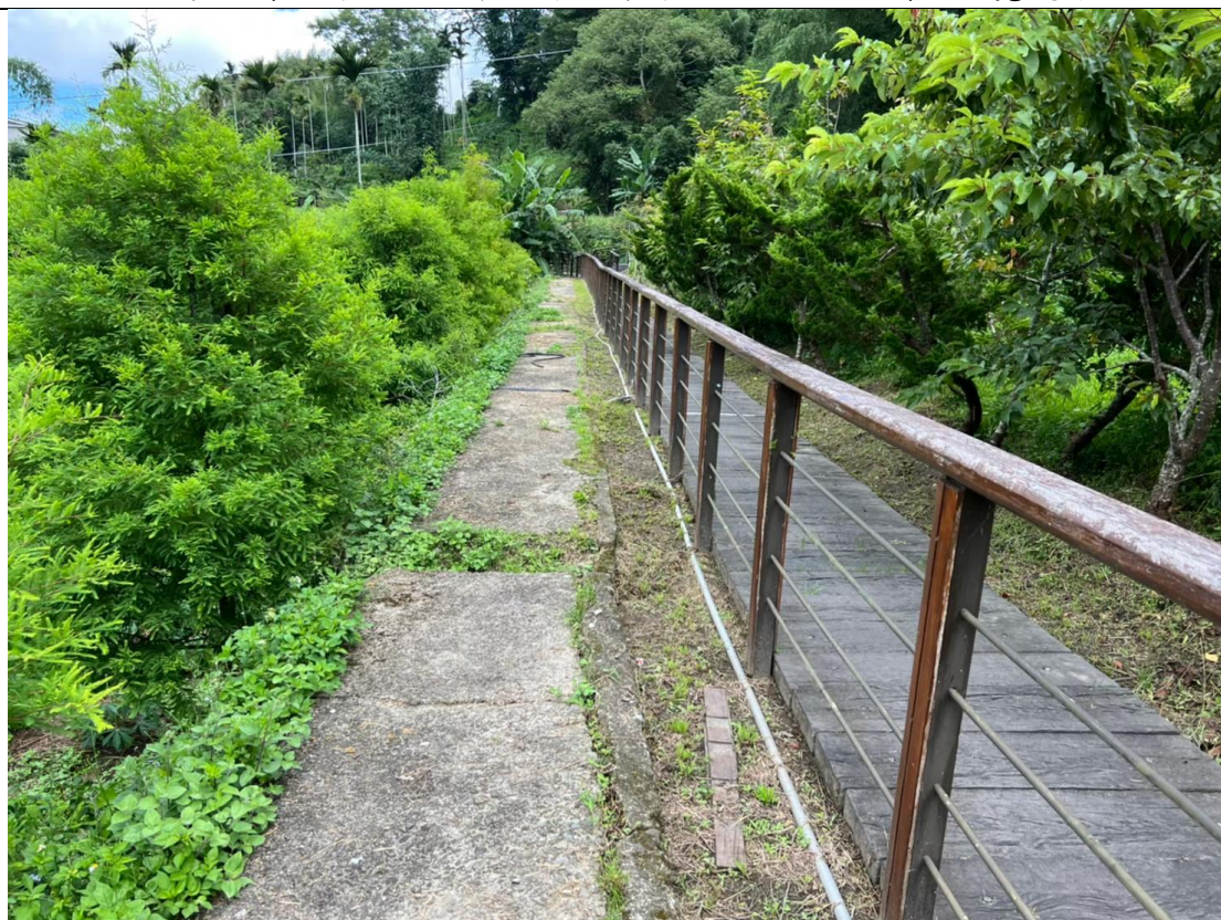
既有欄杆設施損壞，進行維護修建
