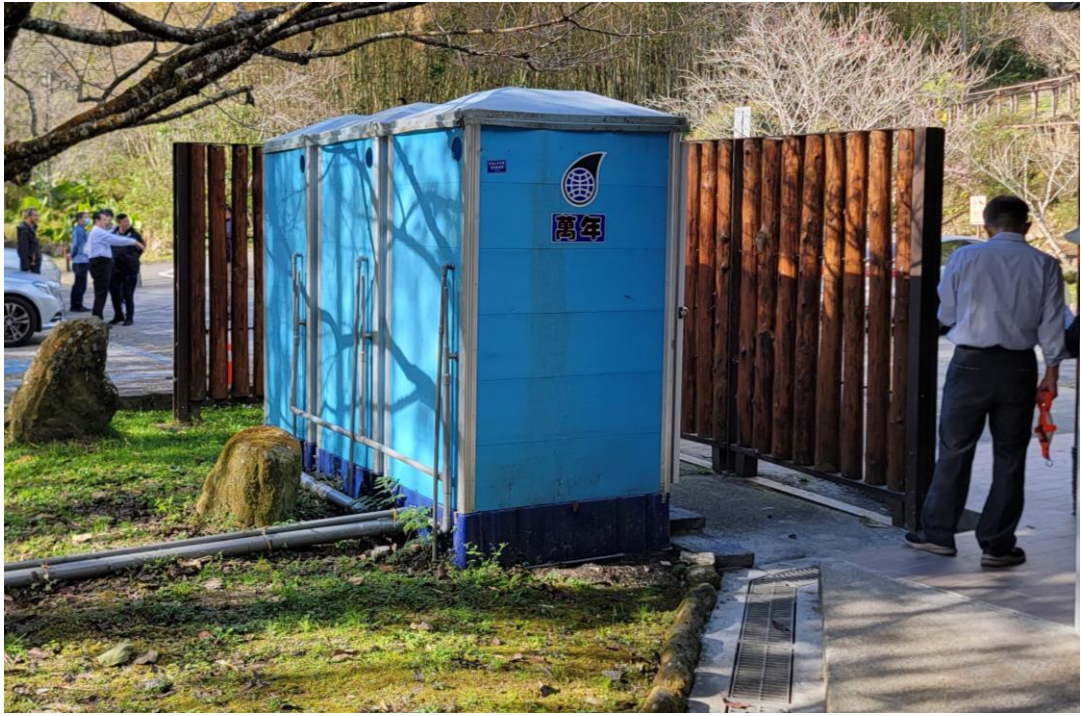
工區五：預鑄廁所施作位置現況照片
