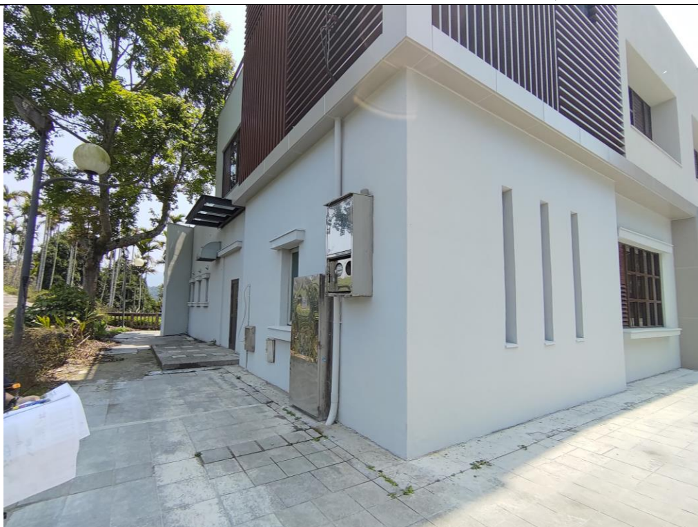
既有瑞太資訊站建築體多處漏水及既有附屬設施建置不周全，進行全面改善
