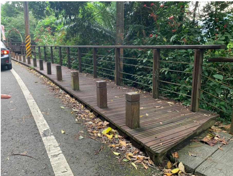
山美既有步道修繕位置照片
