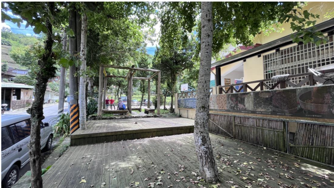
工區四：休憩平台施作位置現況照片
