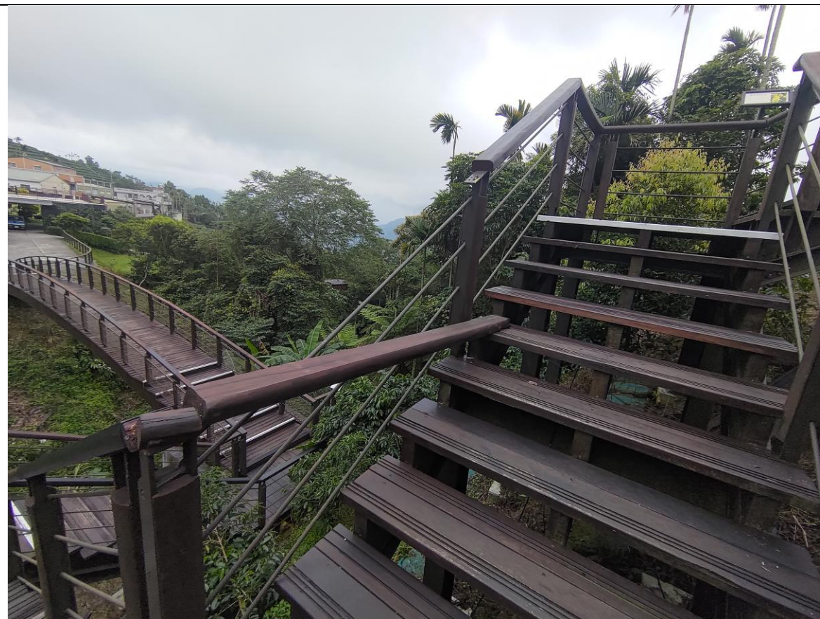
碧湖地區既有木棧橋多處木料損毀，進行整體改善
