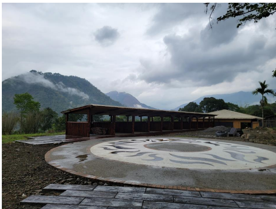
茶山部落生活文化園區入口施作位置照片
