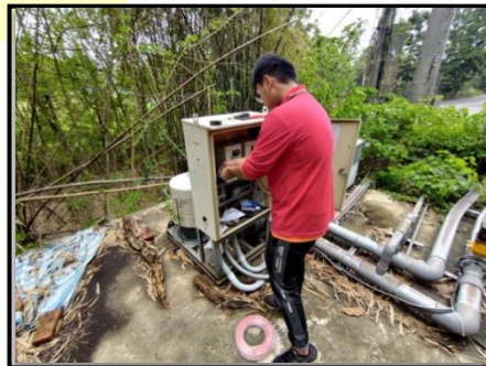
112.01.30蓄水池無熔絲開關修繕
