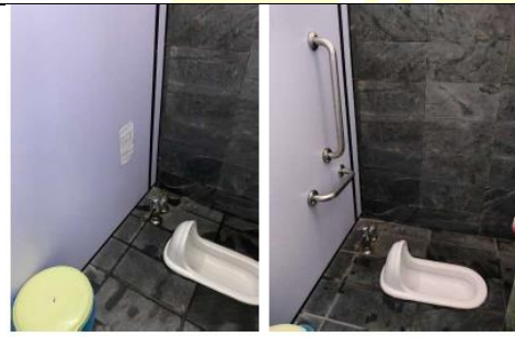
轄區經管公廁蹲式廁間加裝倒T型扶手
