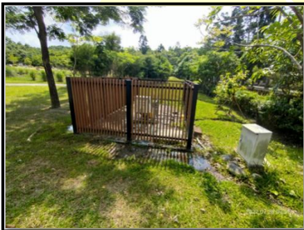
112.01.10八田循環水池設施修繕
