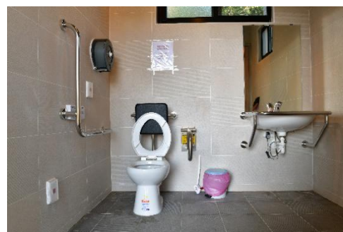
大內頭社夜祭場無障礙公廁改善
