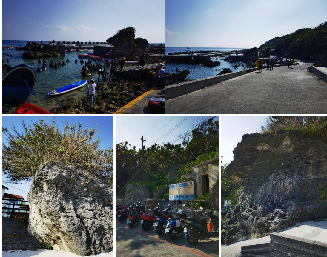
圖 14 大福西修繕工程勘查現況
