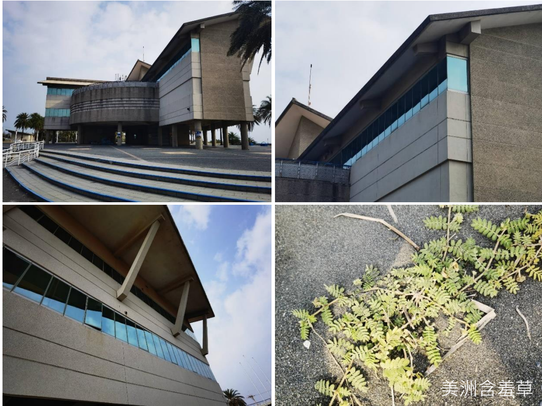
圖 7 青洲濱海遊憩區遊客中心勘查現況
