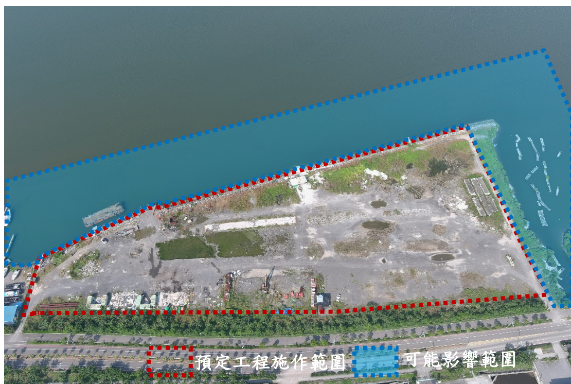
圖 11 大鵬灣水服區遊艇帆船基地興建工程預定範圍環境現況
