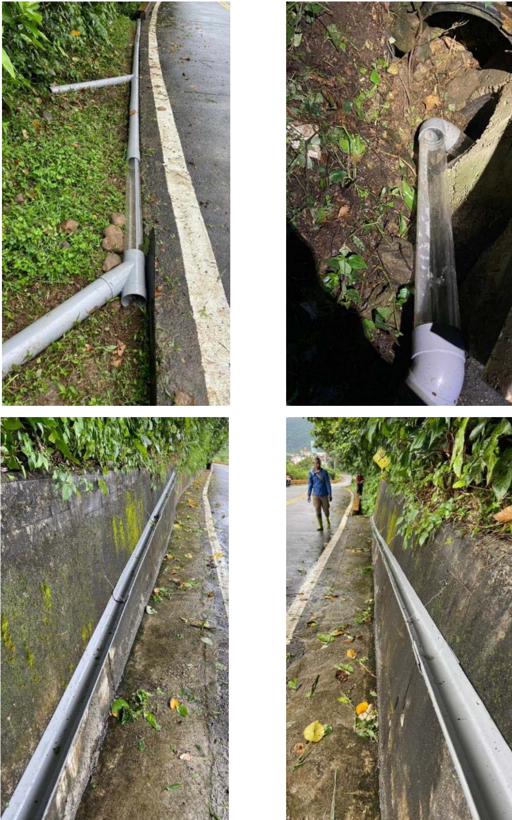
圖 26. 涵洞旁地面及擋水牆上剖半之 PVC 導引管。
