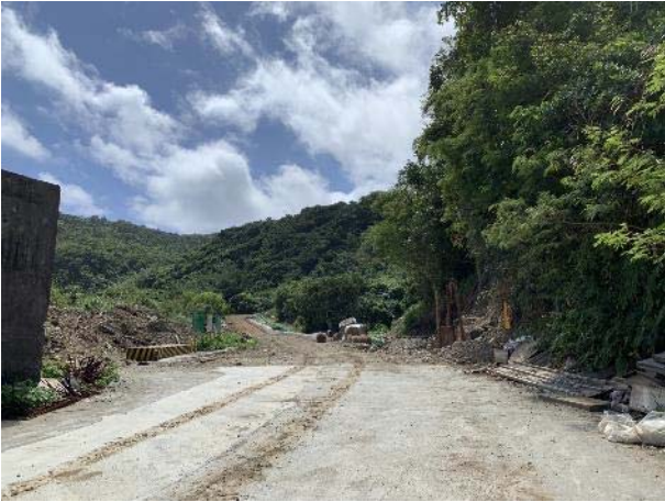
a. 過山古道東側入口處施工。(5 月調查時尚未完工)
