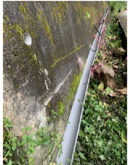
(b) 右側擋土牆水管架設
