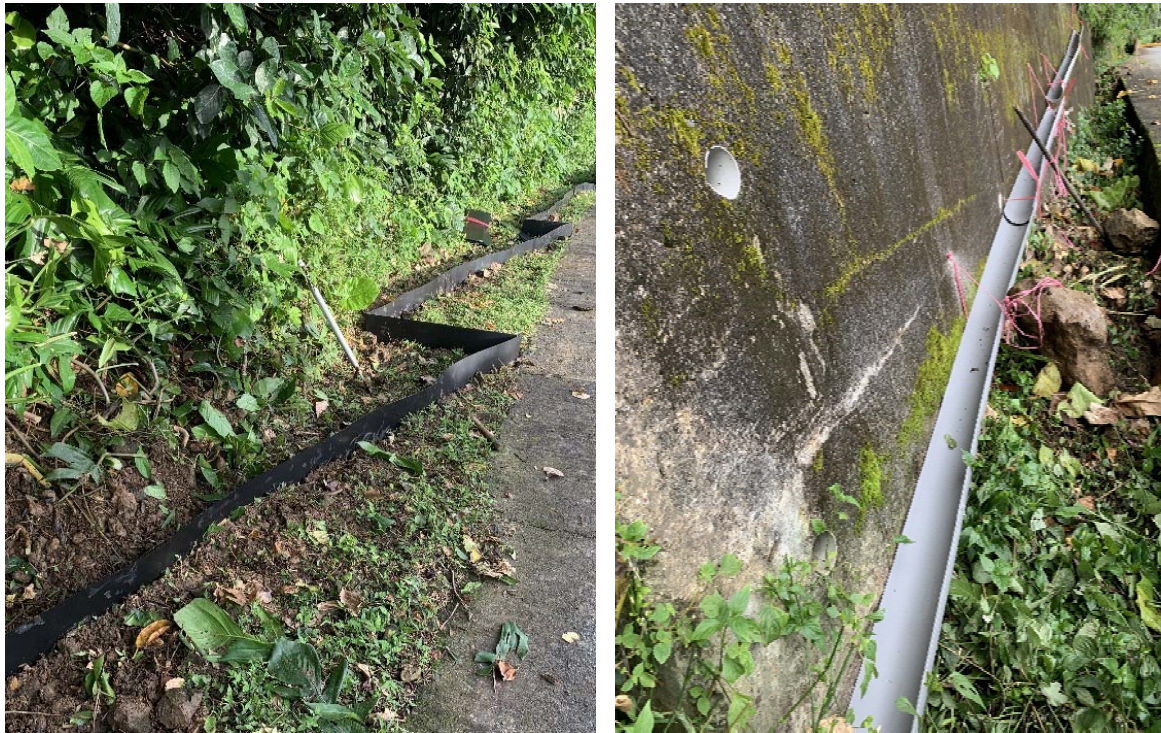
圖 44. No.3 涵洞左側擋板(a)及右側擋土牆水管(b)現場架設照片
