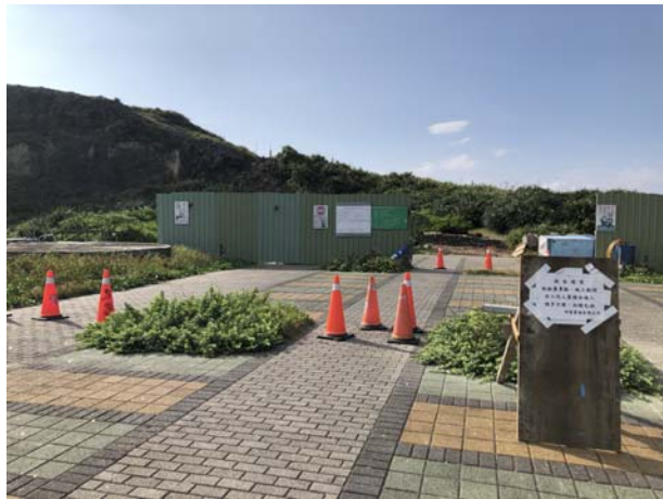
d. 帆船鼻入口及步道進行施工。(5 月調查時已完工)
