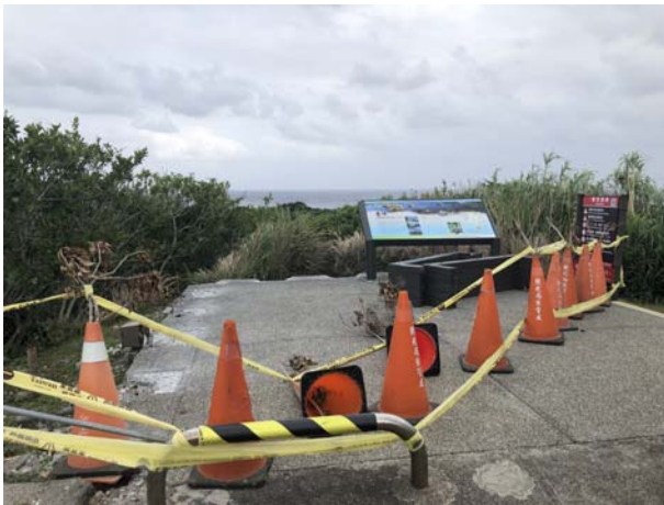
c. 紫坪步道入口處進行施工。(5 月調查時已完工)
