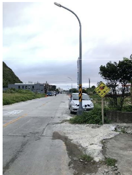
f. 已完成柴口路段路面鋪設，並設立路殺警語標誌。
