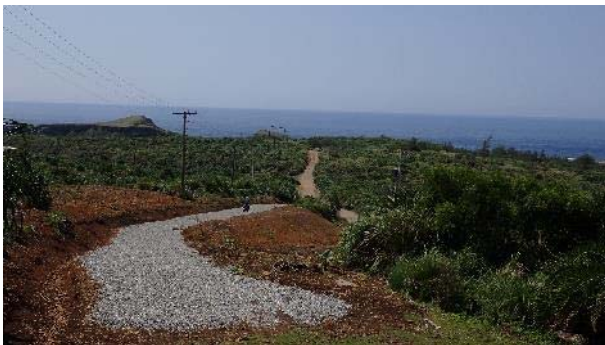
e. 5 月份過山步道東側入口處施工照。
