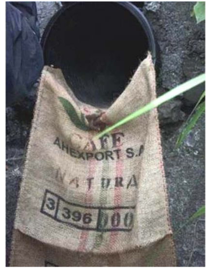
(d) 涵洞靠海端出口所架設之麻布袋
