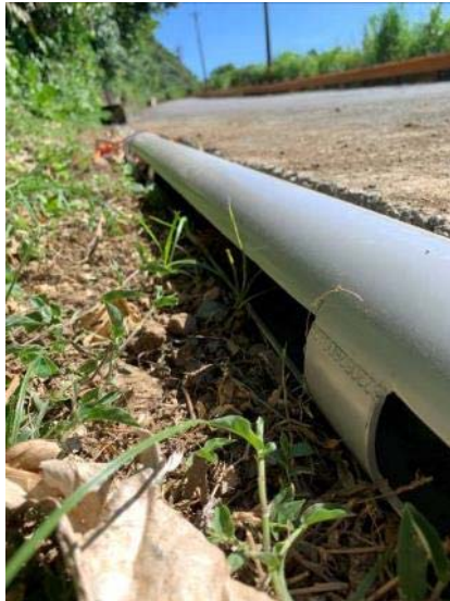
(c) 左側 7-9 月水管架設，水管挖洞引導陸蟹進入水管，同時不影響從海返回山上的陸蟹
