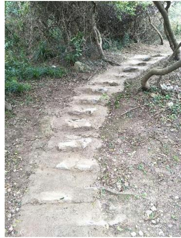
將原本的土坡以石塊疊成階梯狀，形成簡易石階
