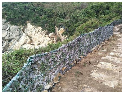
設置簡易圍籬，圍籬打入岩石中做支撐較為穩固，並綁上耐久度較高的尼龍繩作為護欄，最後鋪上綠色偽裝網，呈現戰地特色及美觀。
