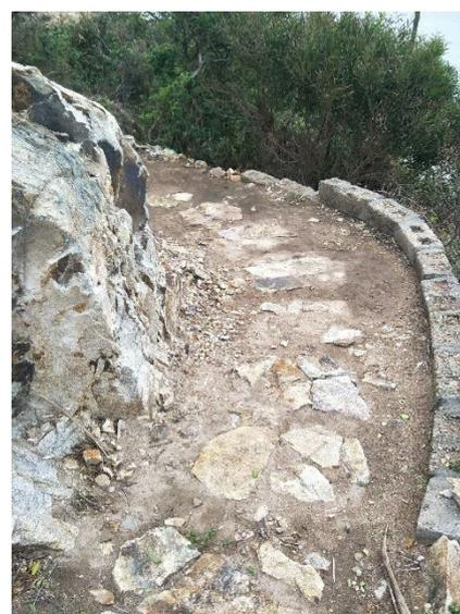
道路的石塊已敲除，路面加寬
