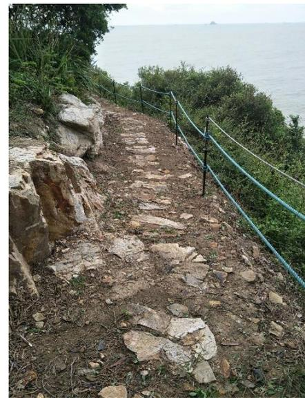
道路拓寬，原突出石塊已敲除，路面整平，並鋪上石塊
