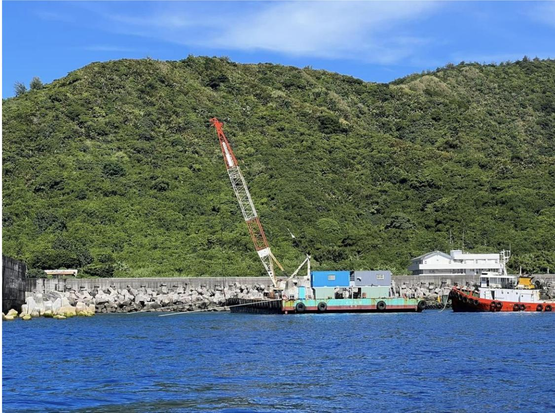
圖70、以拖船穩定平台船的新施工方法 (111.08.16)
