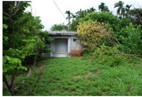
露營區內設施現況
