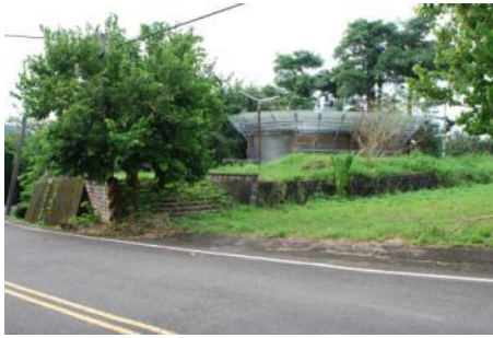
遊客中心現況
