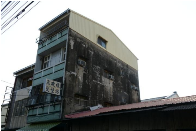
↑ F 棟施作前
