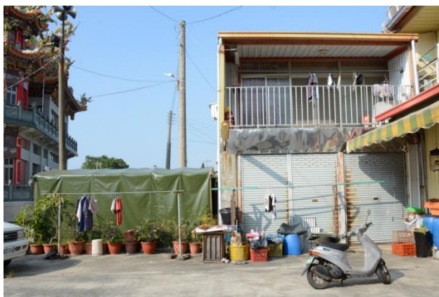
↑ C 棟施作前
