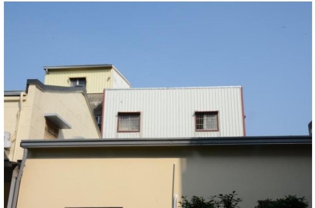
↑ G 棟施作前
