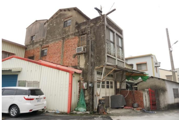
↑ A 棟施作前
