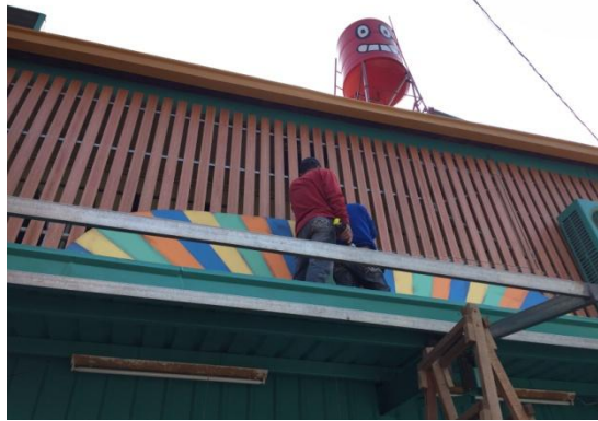
商鋪招牌底板施作
