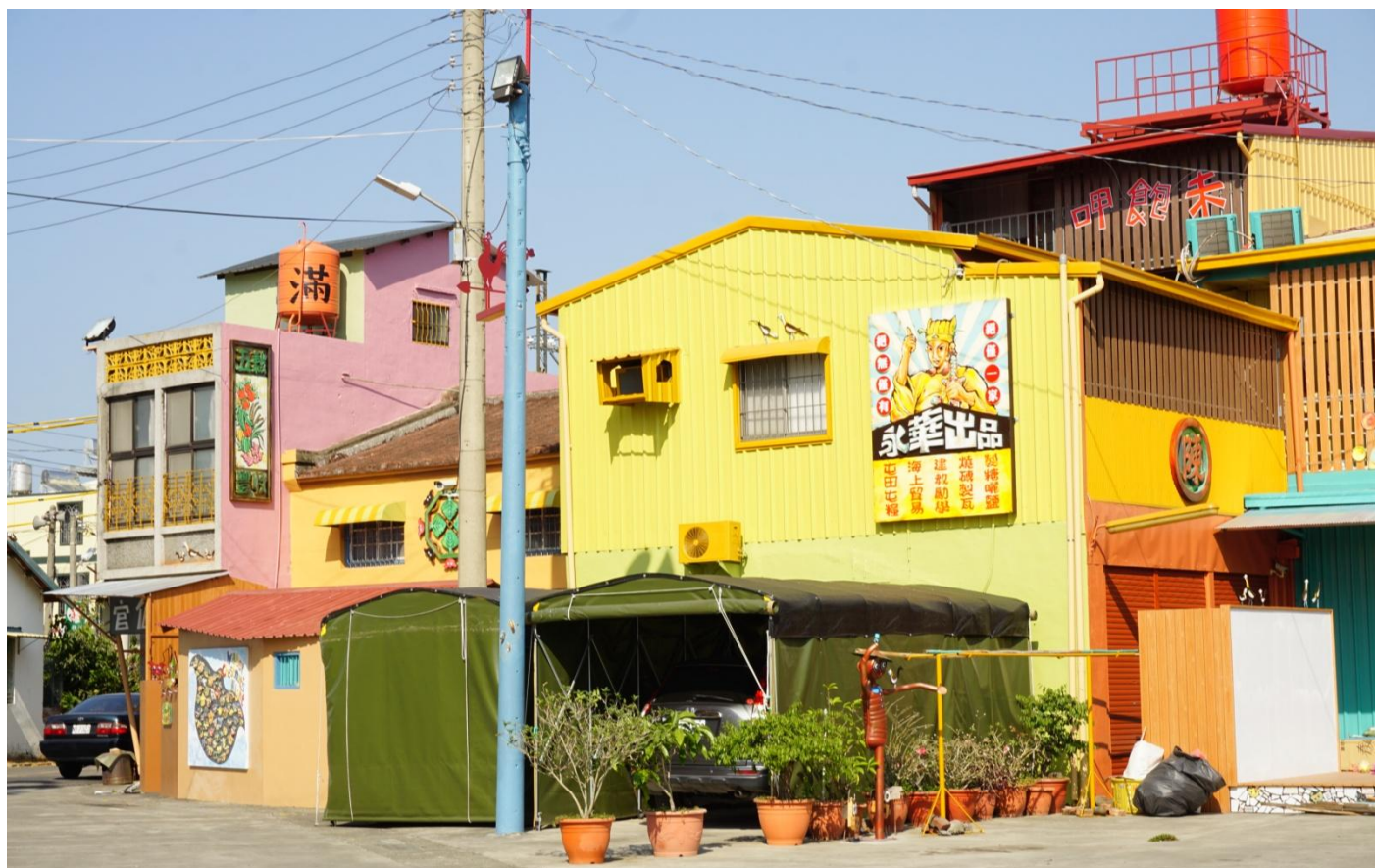
↑ C 棟完成照
