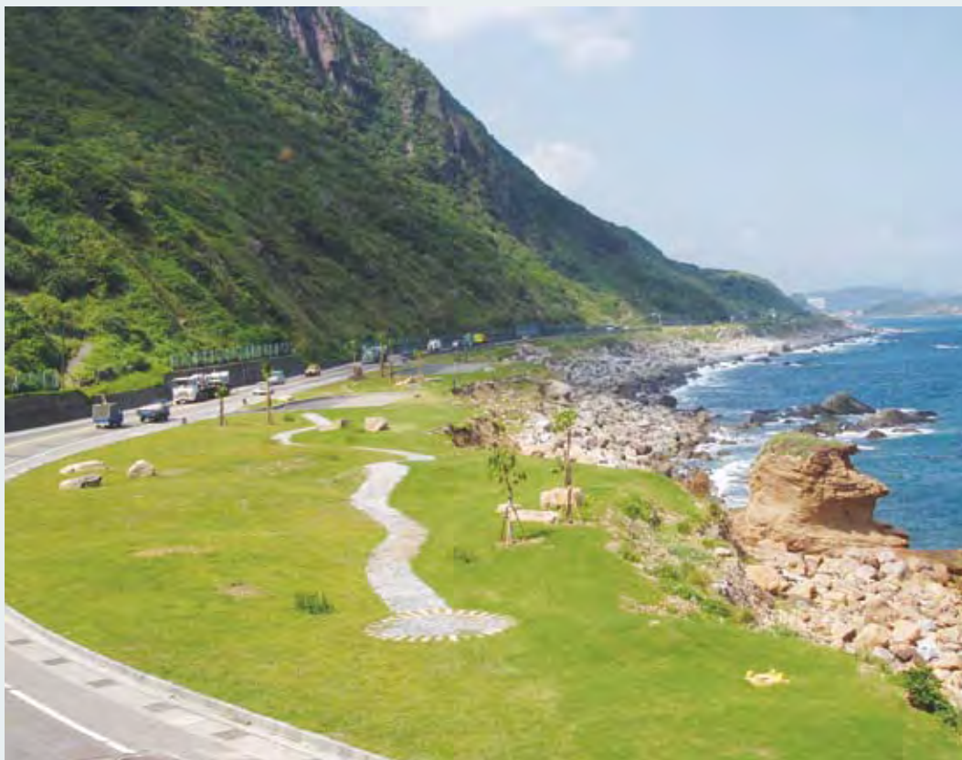
▲台2線80k+500水溝洞—施工後
