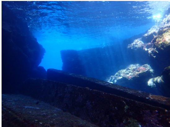
近岸水下有掉落的道路結構物
