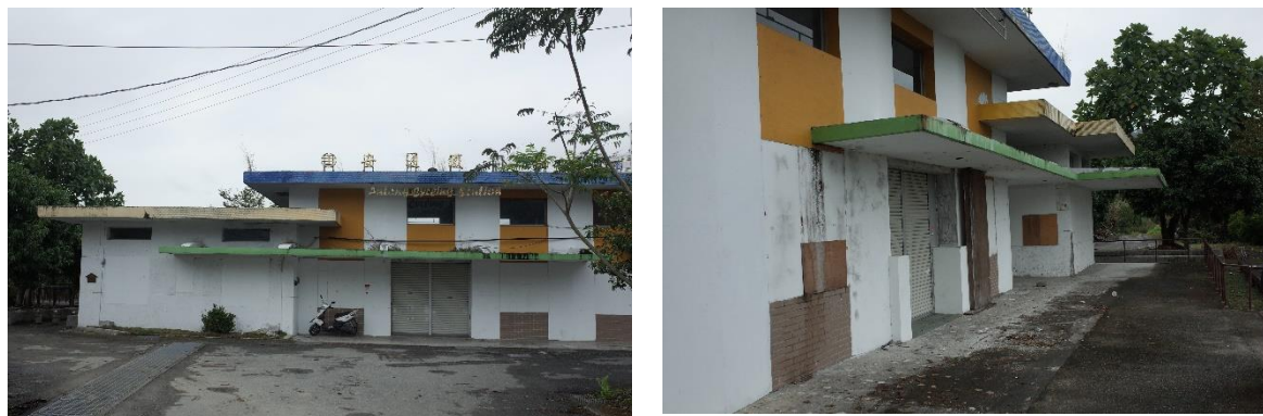
圖117 安通鐵馬站現況照片
