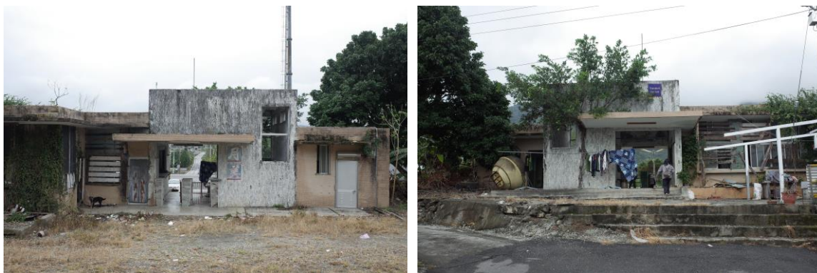
圖123 月美車站現況照片
