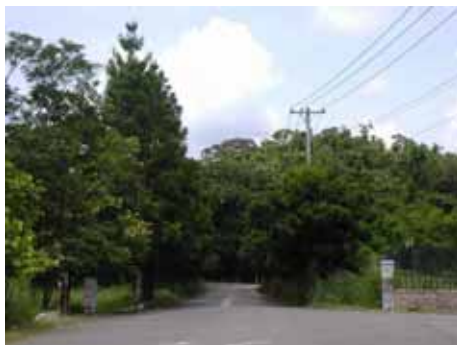
鄉道南 116 線（南 117 線以東路段）現況
