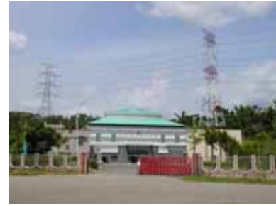
烏山頭水力發電廠
