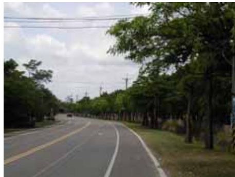
鄉道南 117 線現況
