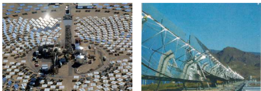
太陽熱能發電系統 左：集中塔式 右：線槽式
