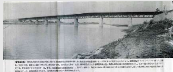
曾文溪水橋（介紹曾文溪水橋為最長的水路橋）
