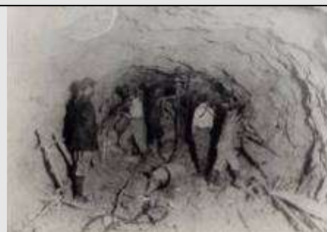
施工中的烏山嶺隧道
