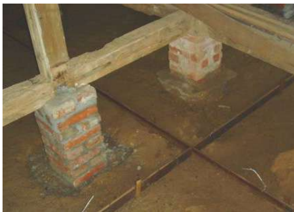
磚砌支柱-金瓜石四連棟日式宿舍
