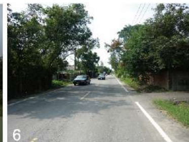
珊瑚路南向現況
