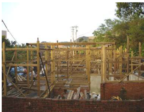
日式宿舍修復之軸組施工情形－金瓜石四連棟日式宿舍
