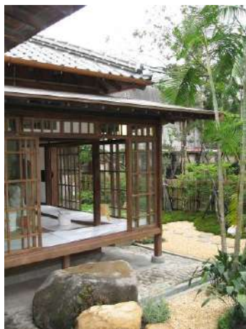
高架地板-台北賓館附屬和館
