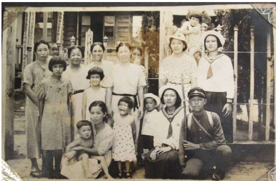
照片拍攝地點為編號 2(八田故居)大門前，其圍牆為鐵欄杆形式
