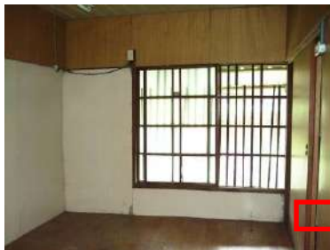
13. 6 帖和室牆面(現況)*
