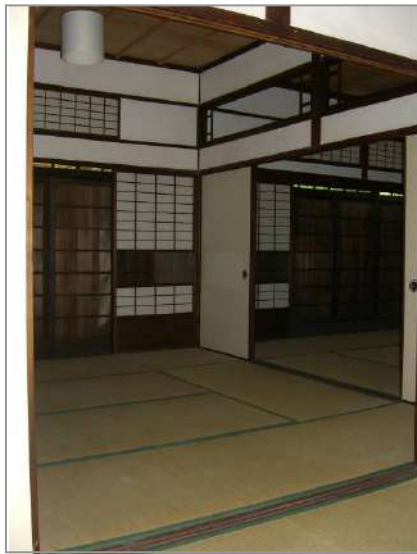
室內採可動壁以增加空間之使用彈性-新竹辛校長故居
