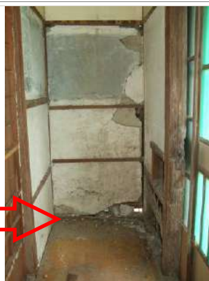
18. 三夾板拆除裝修後， 內為真壁 *注5
