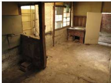
18. 增建部分-水泥砂漿粉光*
