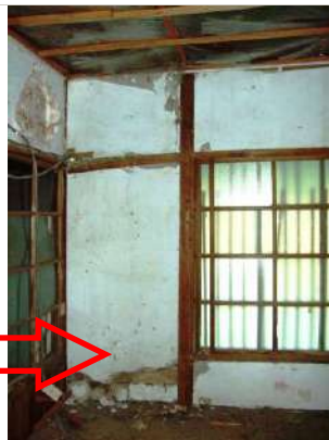
14. 6 帖和室牆面 (夾板拆除後)*
