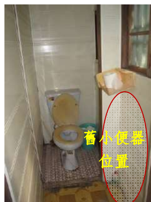
50. 右側牆窗下為舊小便器之位置*
