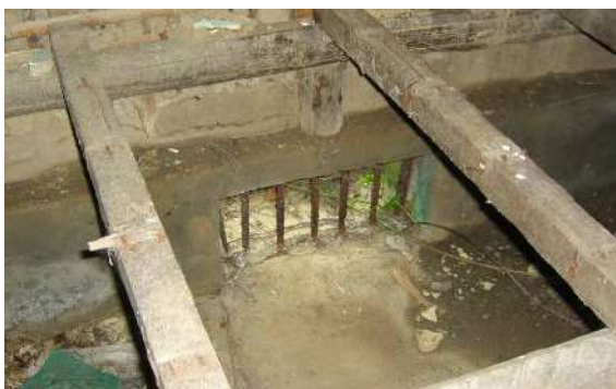
於高架地板基座設置通風口-大溪林務局宿舍
