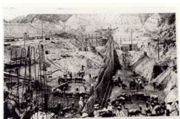
堰堤中心部分施作 (資料來源：陳正美提供)
