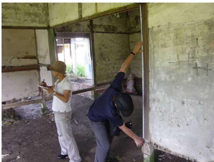
本室內空間容易判讀，助於了解本區建物 (2009.06 中冶拍攝)
