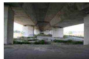
高架橋下景觀
