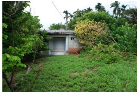
露營區內設施現況
