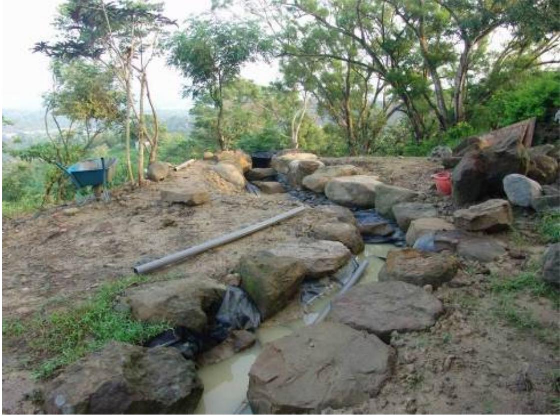
圖 4-17、利用不透水布進行人工溪流底部防水處理
