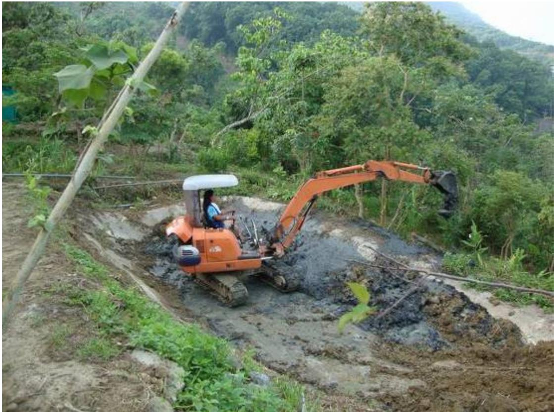
圖 4-10、池底淤泥挖除作業
