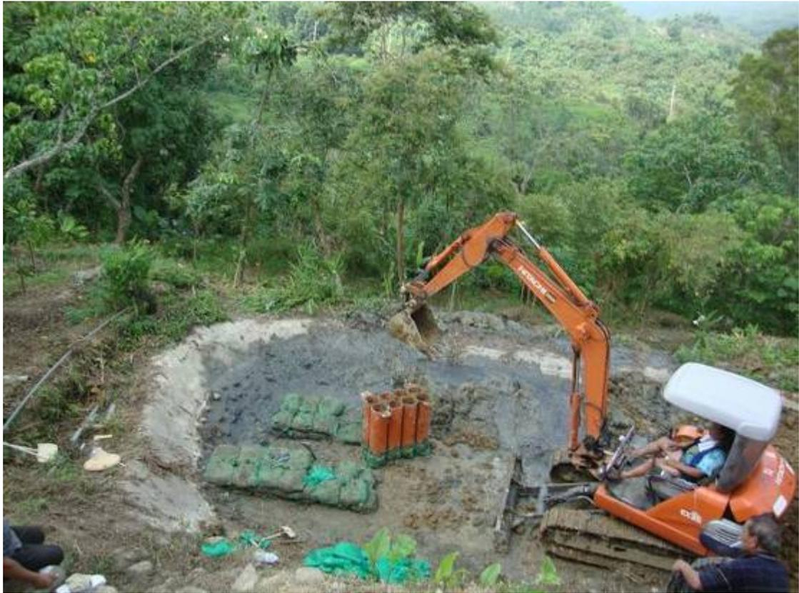
圖 4-11、加進網袋填土及堆置，營造池體地形地貌
