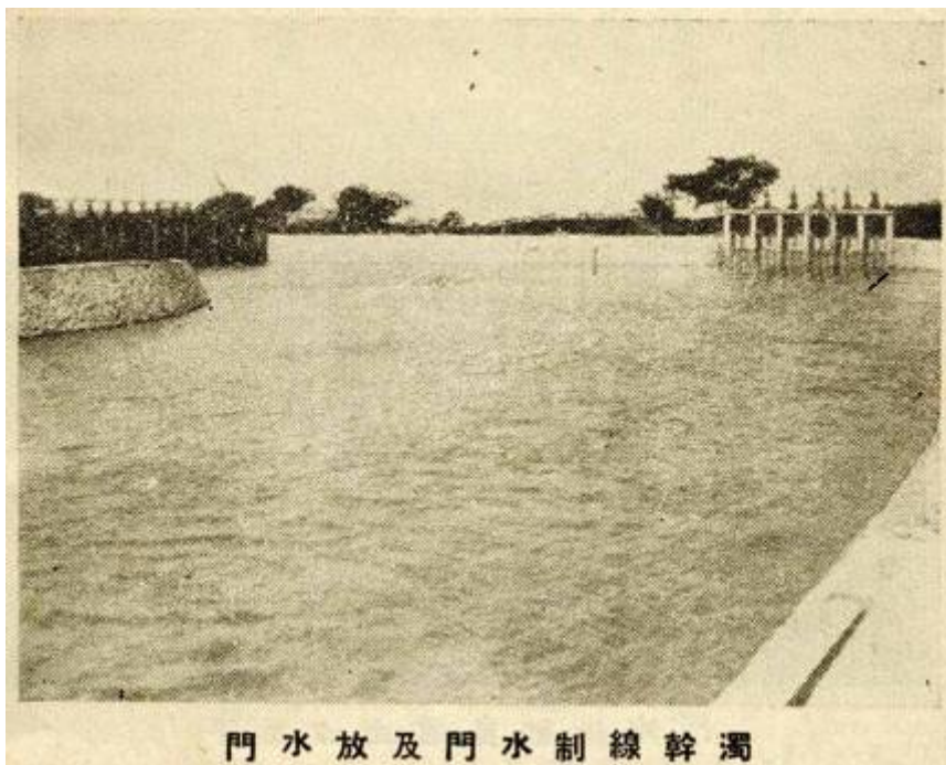
圖 2-10 濁幹線制水門及放水門 31 。
