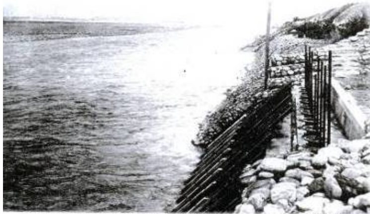
嘉南大圳濁水溪本流取入口
