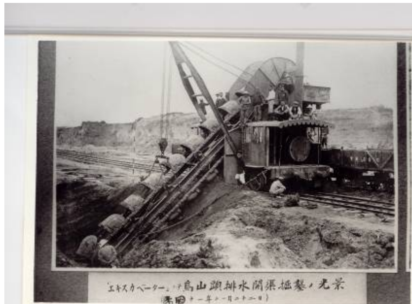
圖 2-14 排水開渠掘鑿光景 35 。
