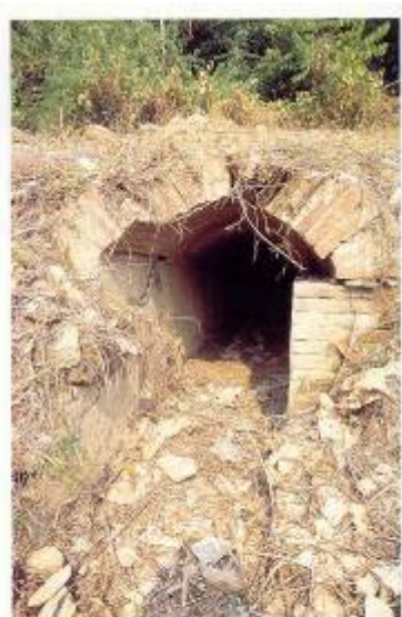
荷蘭壩遺址 漢人移民墾墾地，也帶來確便土地灌溉的水利文化，建立「有土斯有財」的觀念。在烏山頭水庫的一角可以發現荷蘭時代與清領時期的水利設施。因年久失修，只留殘存早年設施的大概。
