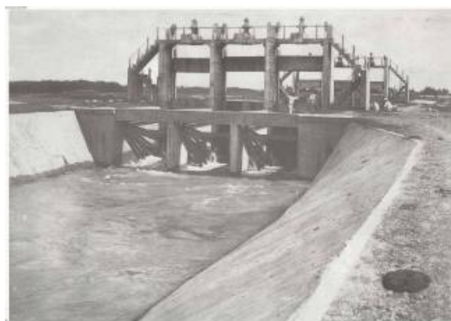
圖 2-13 南北幹線分水門 34 。
