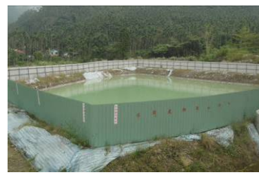
原中崙國小溫泉沈澱池
