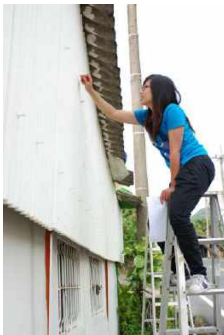
牆壁彩繪施工中
