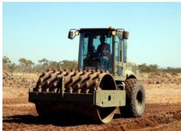
圖 4-8 落錘腳壓路機
