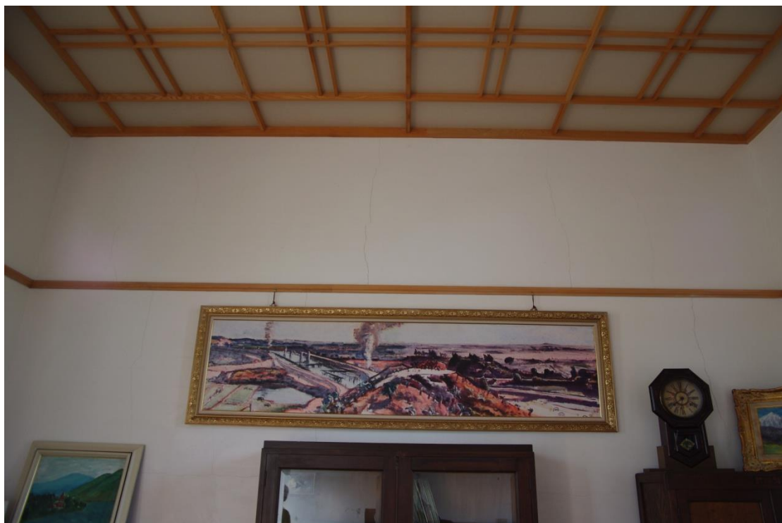
【照片 2-6】八田宅應接室 15 帖之室內牆面出現垂直與水平細微裂縫
