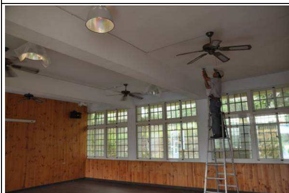
水電配線完成
