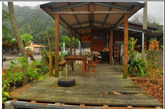
施作前空間外部現況
