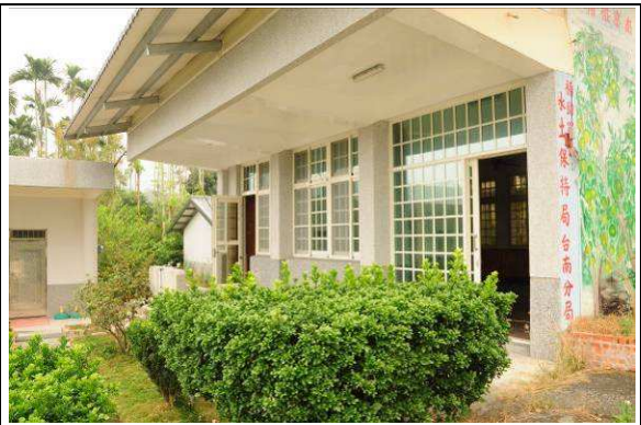
施作前空間外部現況
