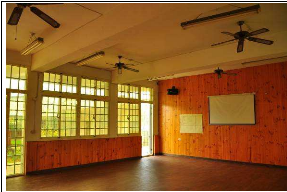
施作前空間內部現況
