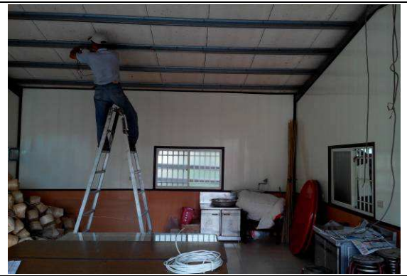
水電配線施作
