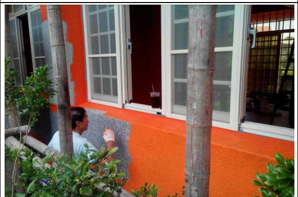
牆面油漆施作
