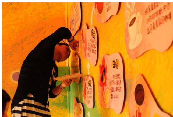
藝術資訊牆施作
