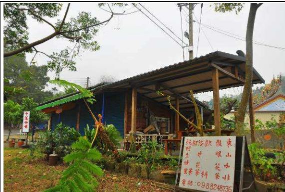
施作前空間外部現況
