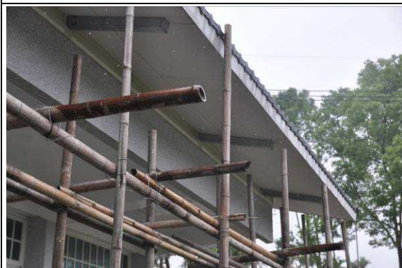
木柱安裝施作
