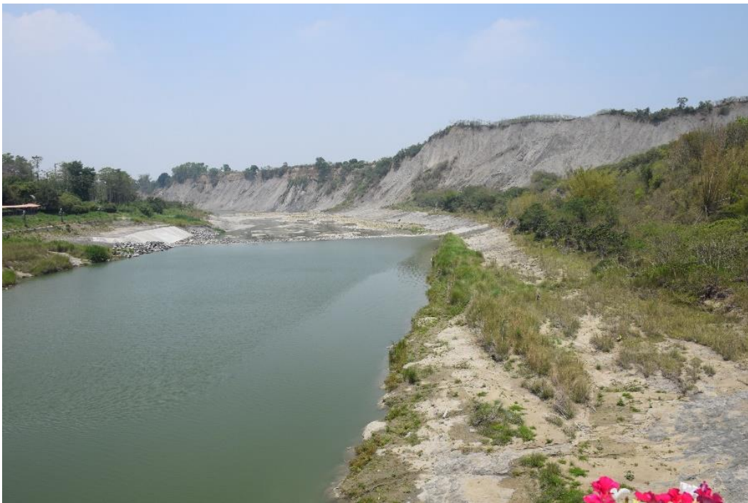
圖 3.22 虎頭埤遊憩區-11-走馬瀨峽谷現況照片
