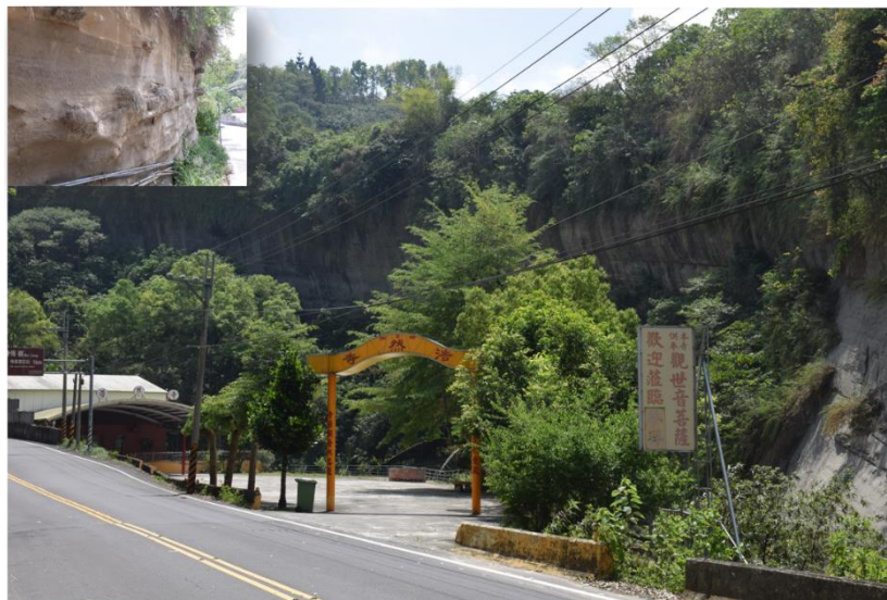
圖 3.29 曾文遊憩區-18-倒轉山現況照片
