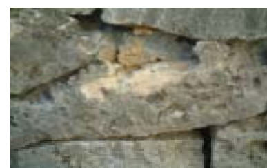
照片 -5-5 咾咕石為珊瑚礁岩，具有良好的隔熱隔音效果
