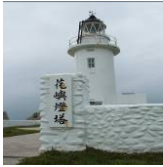
花嶼燈塔是台灣最西的燈塔
