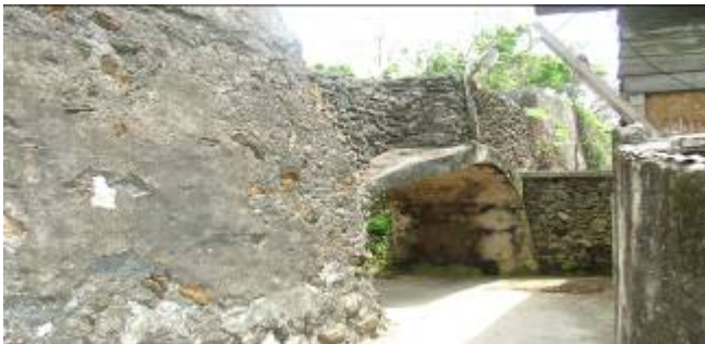
媽宮城西轉西北段城牆仍保存完整
