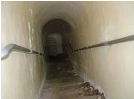
第一賓館地下坑道
