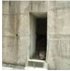
北極殿後防空洞入口
