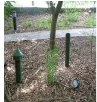
地下坑道通氣口
