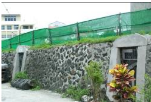
氣象站前防空洞全貌
