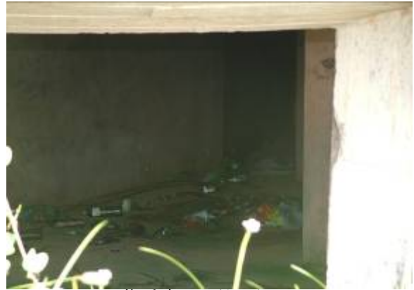
龍門地下碉堡內部
