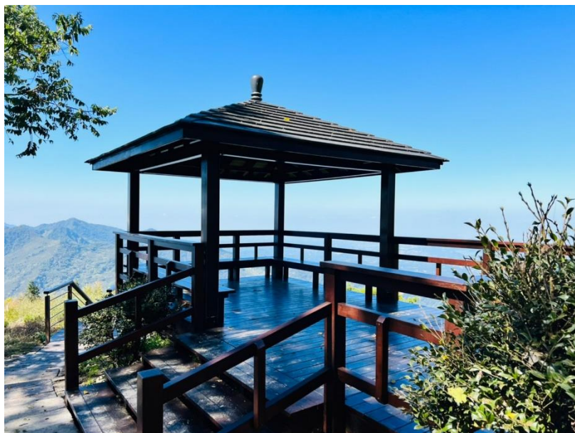
二延平步道涼亭修繕
